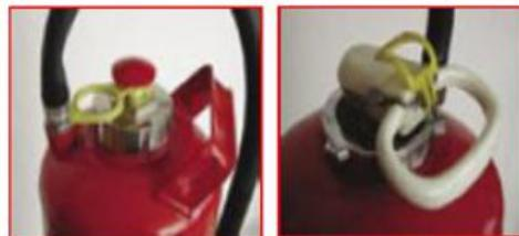
Feuerlöscher müssen gegen unbeabsichtigtes Betätigen gesichert sein. Die Sicherung muss auf jeden Fall zur Inbetriebnahme des Löschgerätes entfernt werden.
