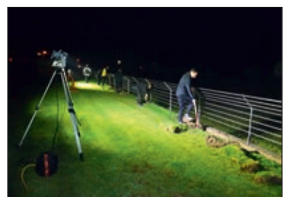
Verlegung eines Erdkabels für die Gerätehütte
