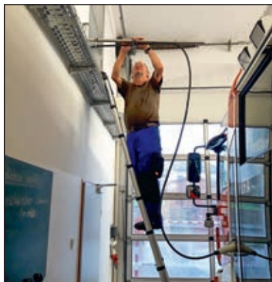
Neuer Strom- und Druckluftanschluss für das neue Löschfahrzeug
