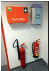
Neuer CO 2 -Löcher und Erste-Hilfe-Koffer im Vorraum
