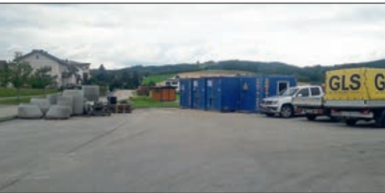
„Bauzentrale“ der GLS am Parkplatz des Feuerwehrhauses
