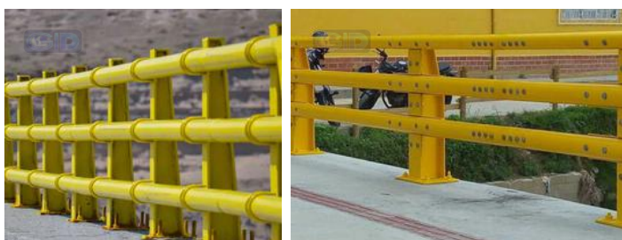
Barandillas de contención
