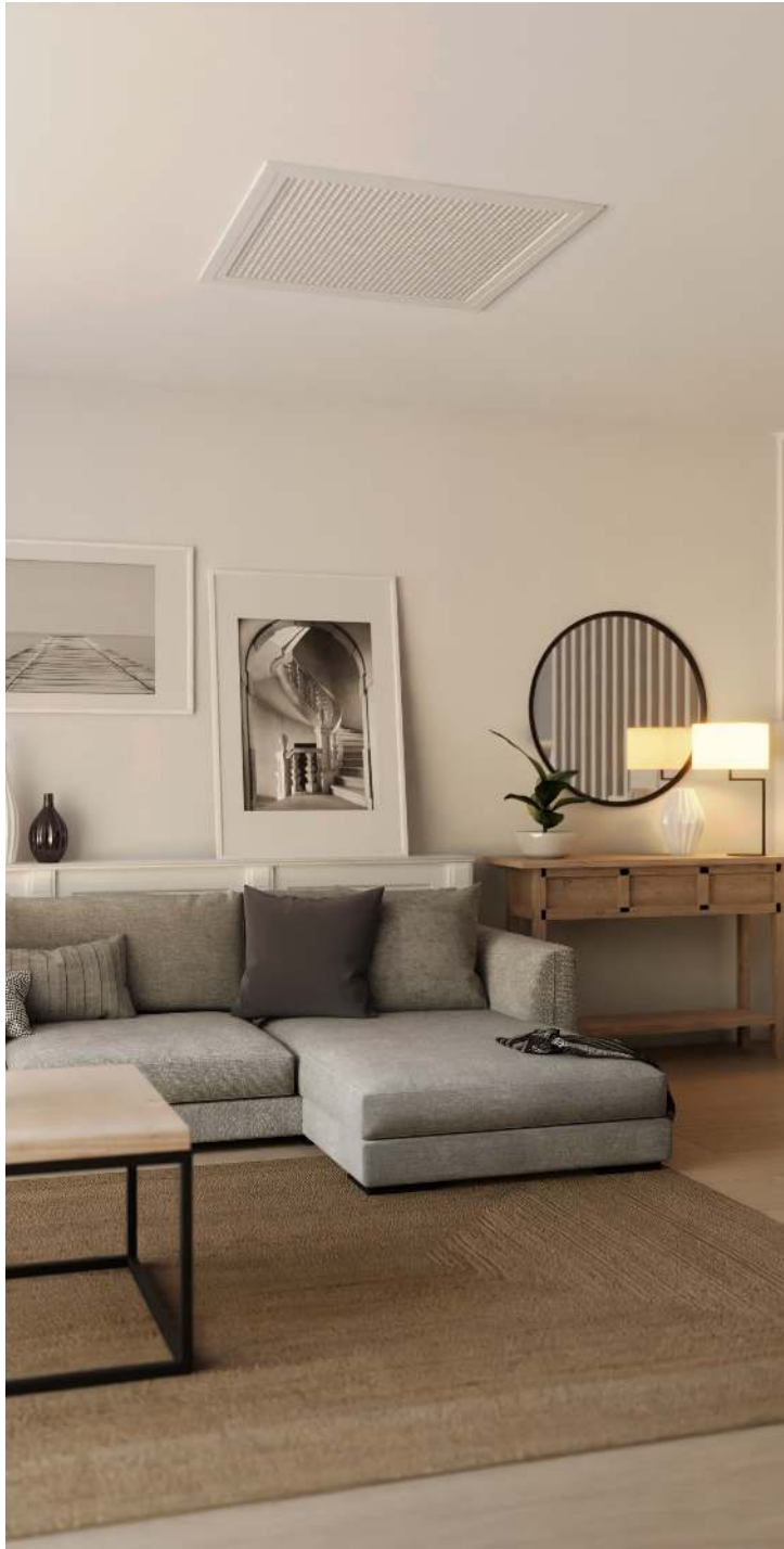
▲ Grille de reprise porte-filtre traditionnelle - position plafonnière
