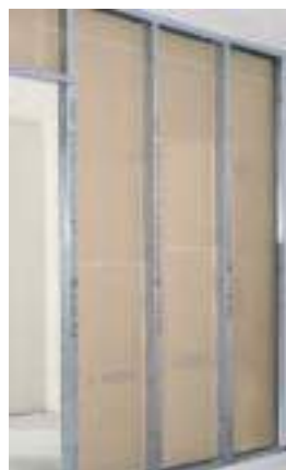
2 Poser les panneaux d'un côté
