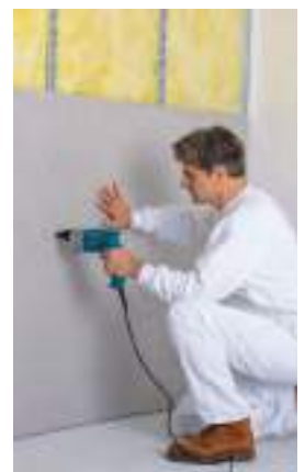
5 Poser les panneaux de l'autre côté
