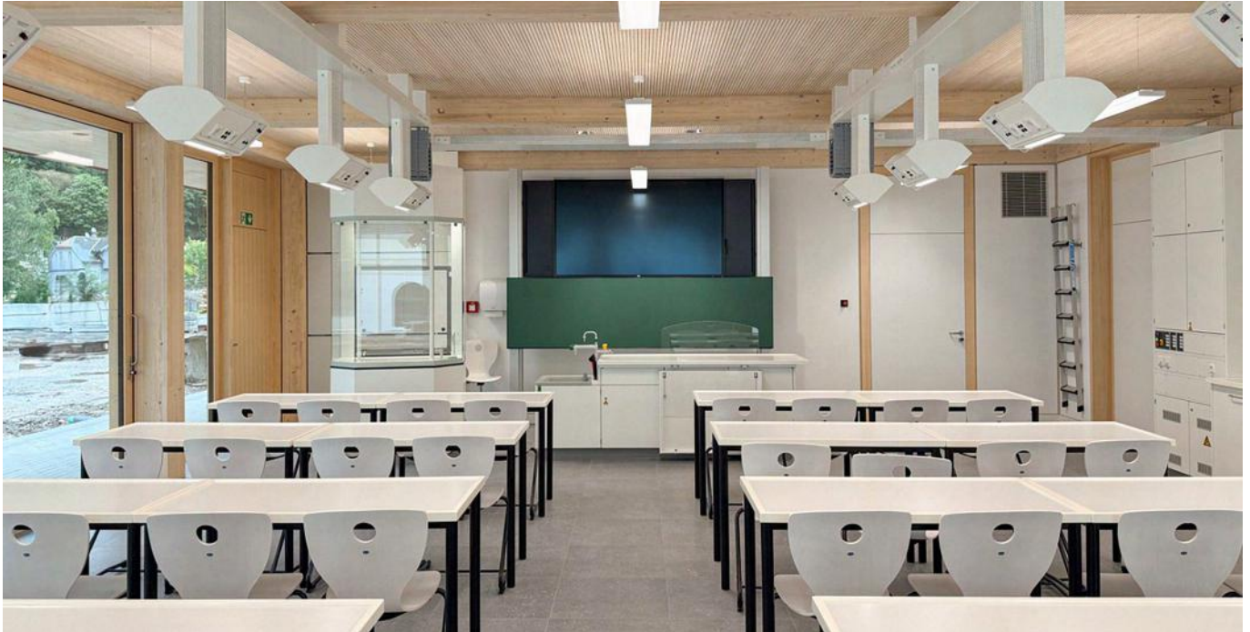
Moderne Klassenzimmer mit Deckenversorgungssystemen
