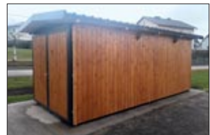
Die renovierte Gerätehütte beim neuen Feuerwehrhaus
