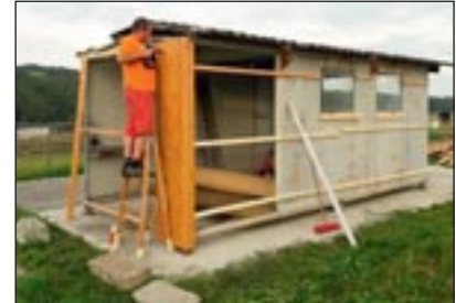
Erneuerung der Fassade
