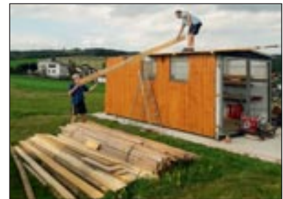
Bau einer neuen Dachkonstruktion
