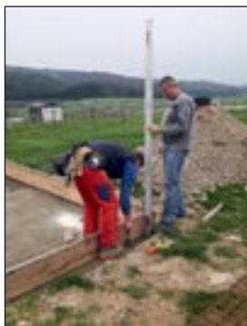
Schalungsarbeiten für das Fundament
