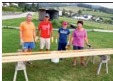
Streicharbeiten für die neue Fassade
