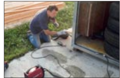
Montage neuer Torrahmen
