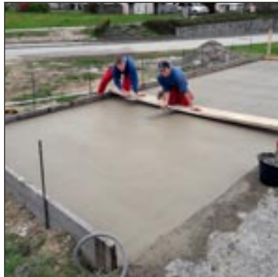
Betonieren Fundament
