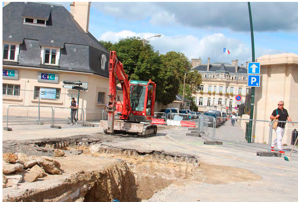
Première tranchée pour le futur réseau de chaleur rue Jean-Chandon-Moët. © l'Hebdo du Vendredi
