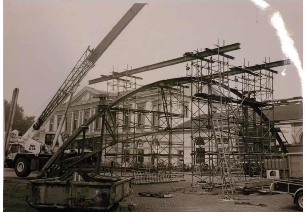
62. Origineel sikkelspant, opgenomen in nieuwe kap. [Collectie Zwolsche Courant, HCO]
