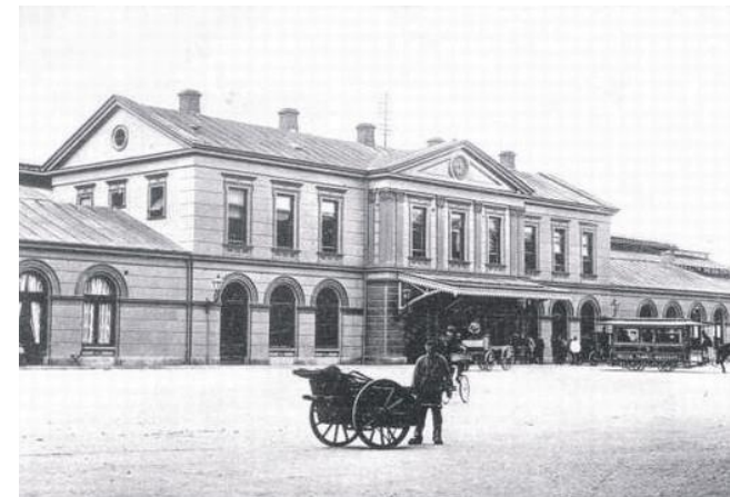
93. Situatie in 1908 met donkere houten kozijnen. [Stationsweb]
