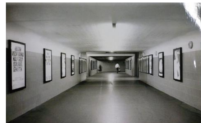
79. De stationstunnel net voordat die doorgetrokken wordt naar de zuidkant van het station, 1986. [Collectie Zwolsche Courant, HCO]
