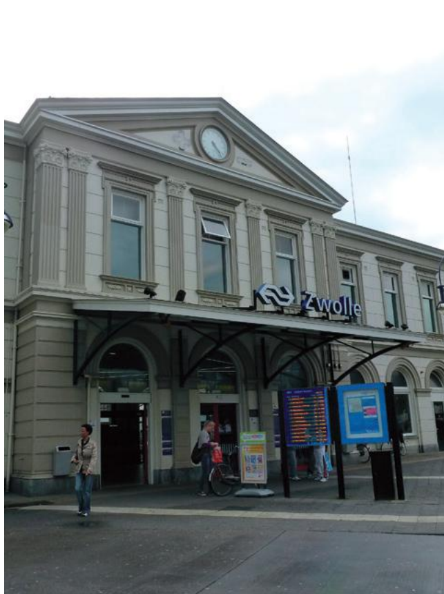
De rond 1891 aangebrachte luifel boven de hoofdentree.
