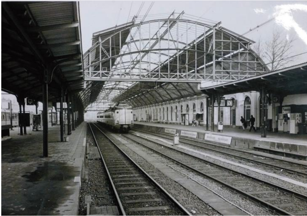
61. Demontage van de originele stationskap. [Collectie Zwolsche Courant, HCO]
