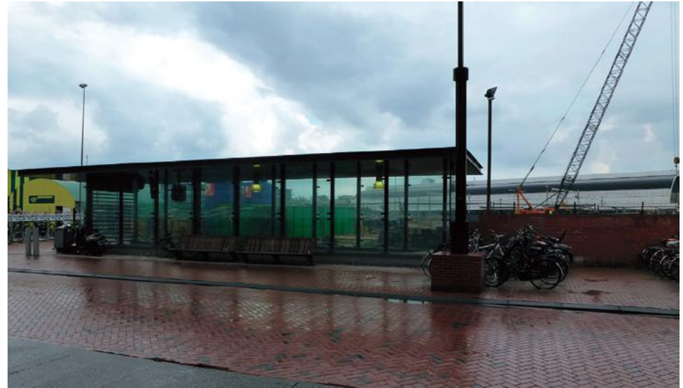
89. Entree reizigerstunnel zuidzijde.
