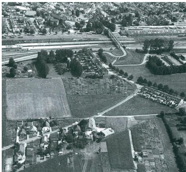
03. De Hoge Brug over het emplacement, omstreeks 1970. [HUA]
