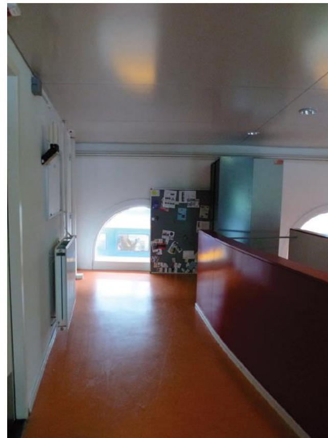
Ingehangen verdiepingsvloer in zijvleugel.
