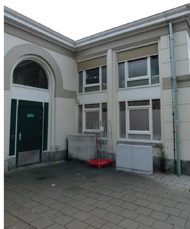
Ramen uit verbouwing 1958 door Van der Gaast.
