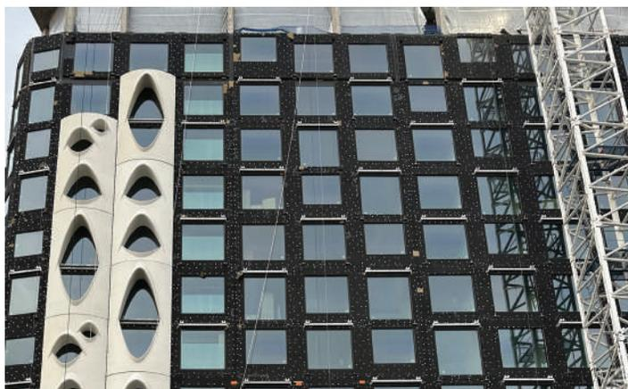
**Fig. 6:** La fachada del hotel Populus durante la construcción. Las áreas negras son la membrana de barrera del muro contra intemperismo. Las bandas metálicas alternas son “toalleros” de acero galvanizado de alta resistencia para colgar los paneles de GFRC blancos (fotografía cortesía de Cannon Masonry)
