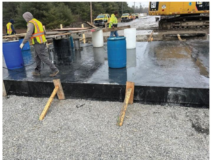
**Fig. 7: Después de la instalación de los paneles y el relleno de los canales longitudinales. Obsérvese el ancho extremadamente reducido de las juntas de los tableros**
