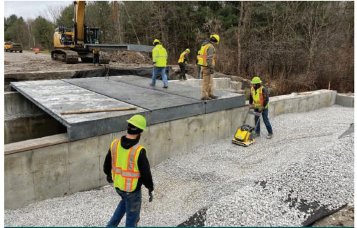
**Fig. 5: Elevación de paneles de UHPC**
