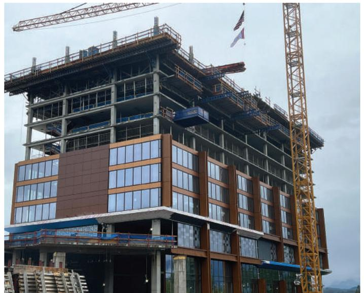
Fig. 8: La estructura del Hotel Snoqualmie Casino es un marco de concreto armado con losas postensadas y dos núcleos de paredes de corte. El diseño fue realizado para acomodar un sistema de encofrado colgado de columnas para la construcción de losas, eliminando así la necesidad de apuntalamiento y reposicionamiento y facilitando el acceso temprano a los trabajadores de MEP y acabados.
