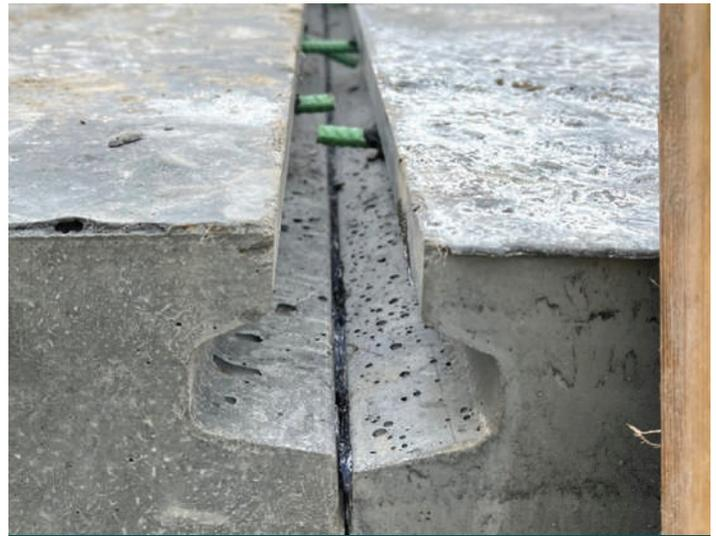
**Fig. 6: Detalle de un canal longitudinal entre paneles adyacentes**
