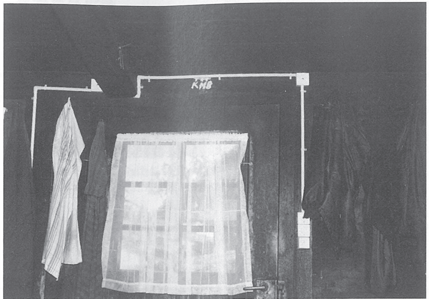
KIR-Rohr-Installation um Ecken und Kanten.
