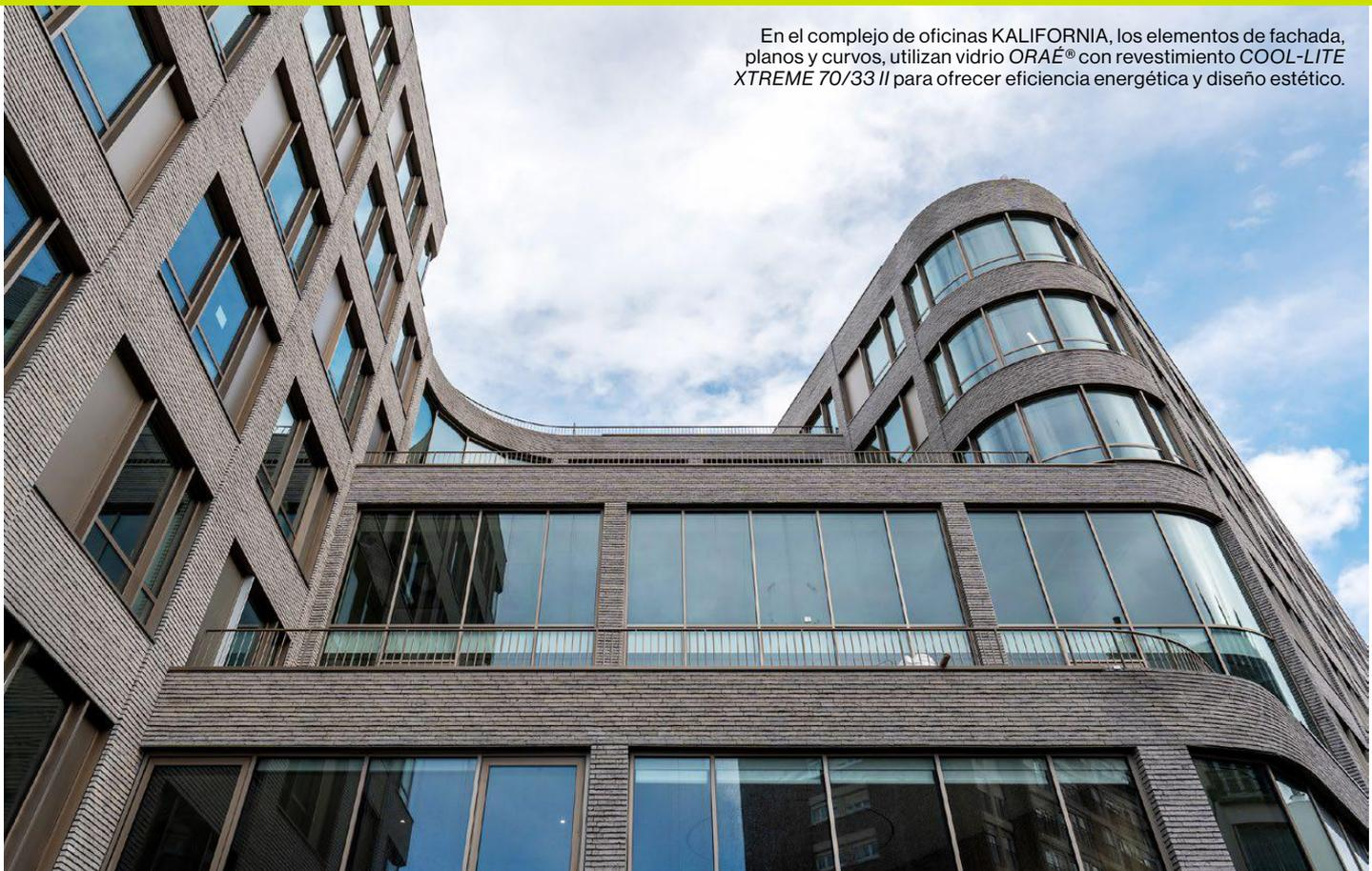
En el complejo de oficinas KALIFORNIA, los elementos de fachada, planos y curvos, utilizan vidrio *ORAÉ*<sup>®</sup> con revestimiento *COOL-LITE XTREME 70/33 II* para ofrecer eficiencia energética y diseño estético.
