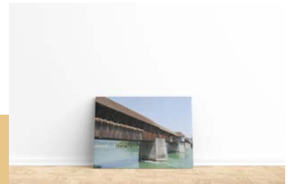
4486-262 Bad Säckingen Hochrhein Holzbrücke
