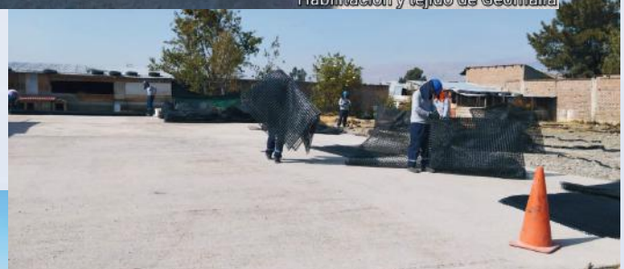
21 ago 2023 10:00:39 a. m. Habilitación y tejido de Geomalla
