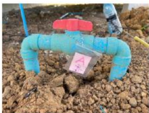
ติดตั้งวาล์ว เปิด ปิด สมัยจากใต้ดิน
