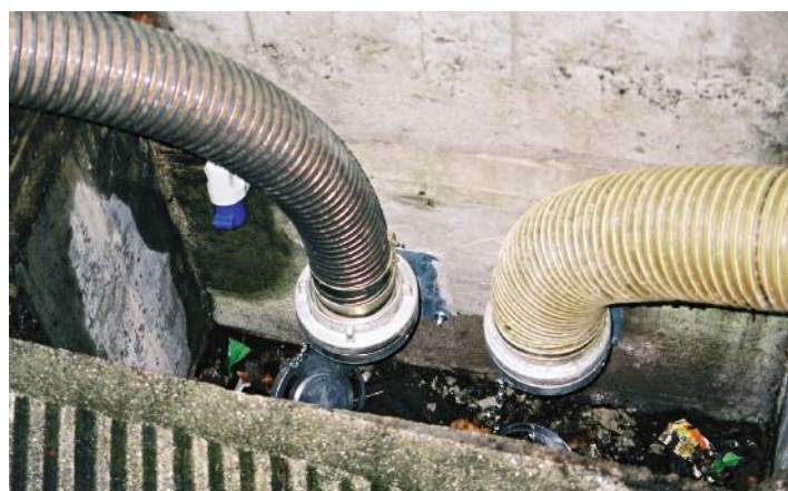
Durch den linken Schlauch werden die Pellet vom Tankwagen eingeblasen, durch den rechten wird der Überdruck und der Staub abgesaugt, mit Staubsack gereinigt.
