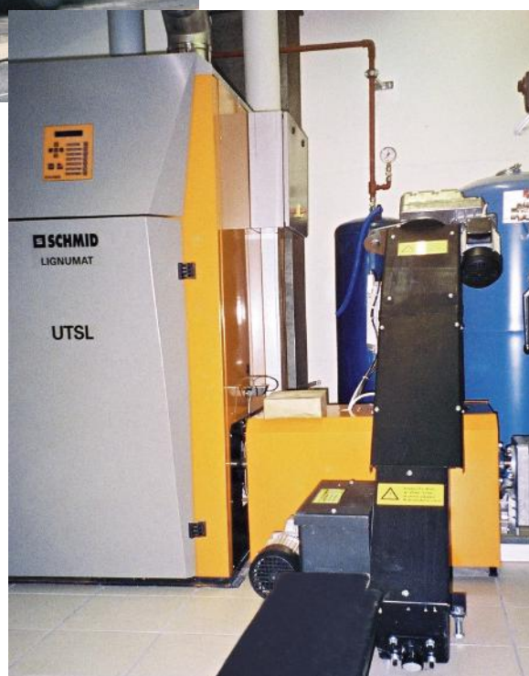
Der Holz-Kessel mit der Förderanlage der Holz-Pellet.
