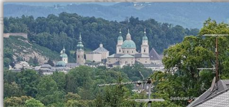
Blick von oberer Terrasse
