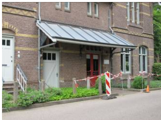
Plaatsing palen langs voorzijde stationsgebouw (na 2000)
