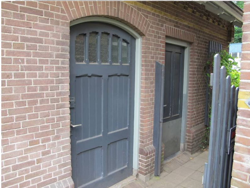
Boven een detail van de gevel- en dakdetailering van het bijgebouw. Onder de enige nog oorspronkelijke deuropening en rechts een later toegevoegde deuropening.
