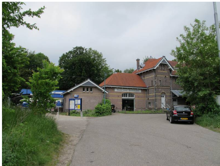
Zicht over de Stationsweg in westelijke richting met links de toegang tot het perron en de leverancierstoegang van de Welkoop
