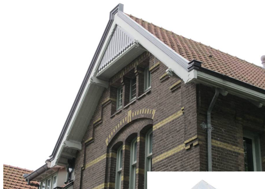
Overzicht van één van de topgevels boven de oostgevel.
