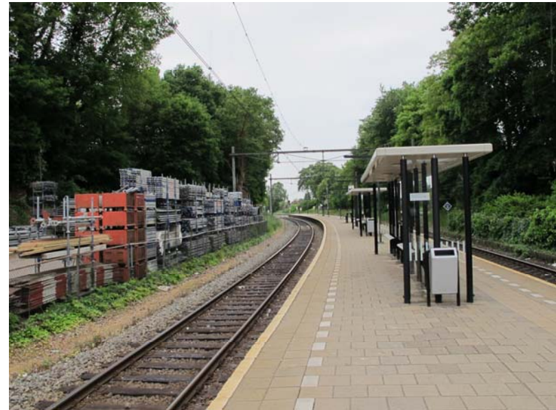
Zicht over het eilandperron in noordelijke richting, met links het opslagterrein van een bouwbedrijf.
