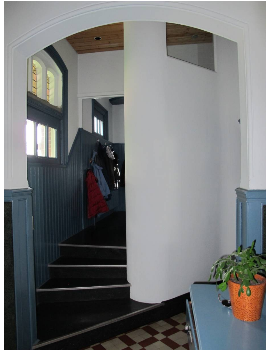
Tussen de vestibule en het trappenhuis nieuw aangebrachte driehoekige toiletruimte met afgeronde hoek.
