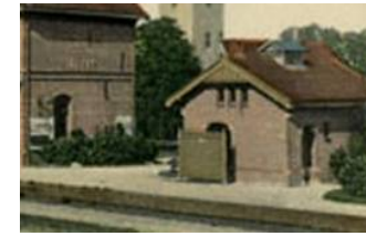
Nevengebouw met sanit voorzieningen
