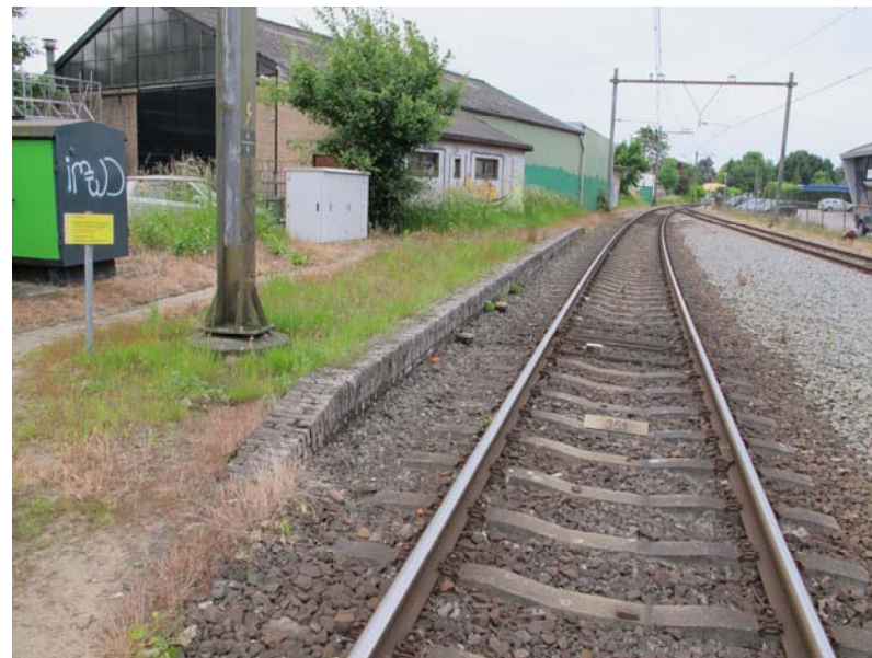
Zicht vanaf het zuidelijke perroneinde op de hier gevestigde bedrijven.
