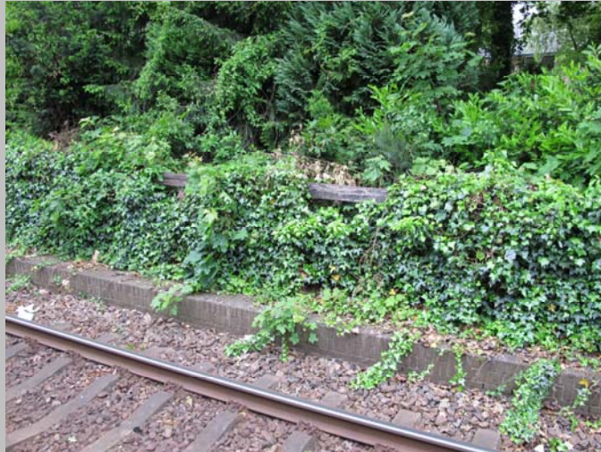
Voorkomen dat groenelementen verwilderen en zo het zicht op historische elementen wegnemen
