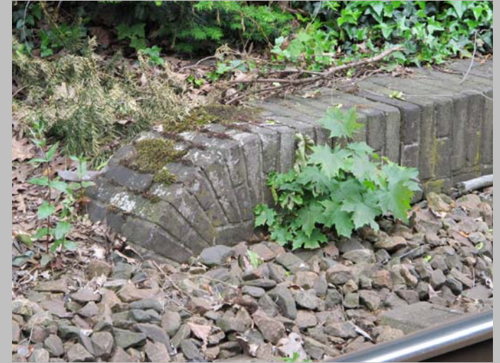
Oorspronkelijke perronopzet nog afleesbaar
