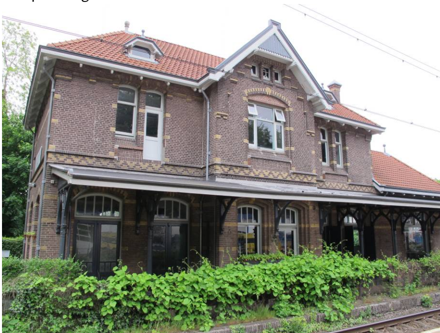
Overzicht van het stationsgebouw vanuit het westen. Aan deze zijde wordt het zadeldak onderbroken door het zadeldak boven de risaliet.
