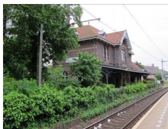
Zicht op stationsgebouw
