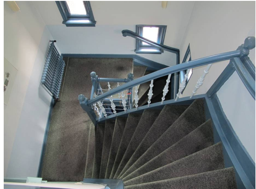
Overzicht van het trappenhuis, gezien vanaf de zolder. Linksonder enkele details van de oorspronkelijke trap.
