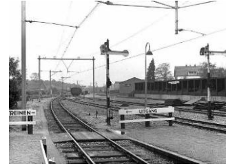
Goederenterreinen buiten gebruik (1972)
