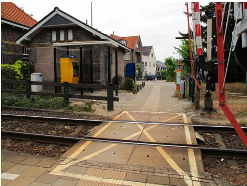
Toegang tot het perron langs de zuidzijde van het bijgebouw.
