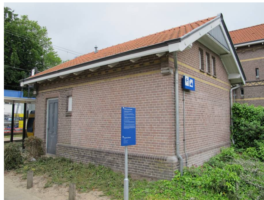
Overzicht bijgebouw vanuit het zuidoosten.
