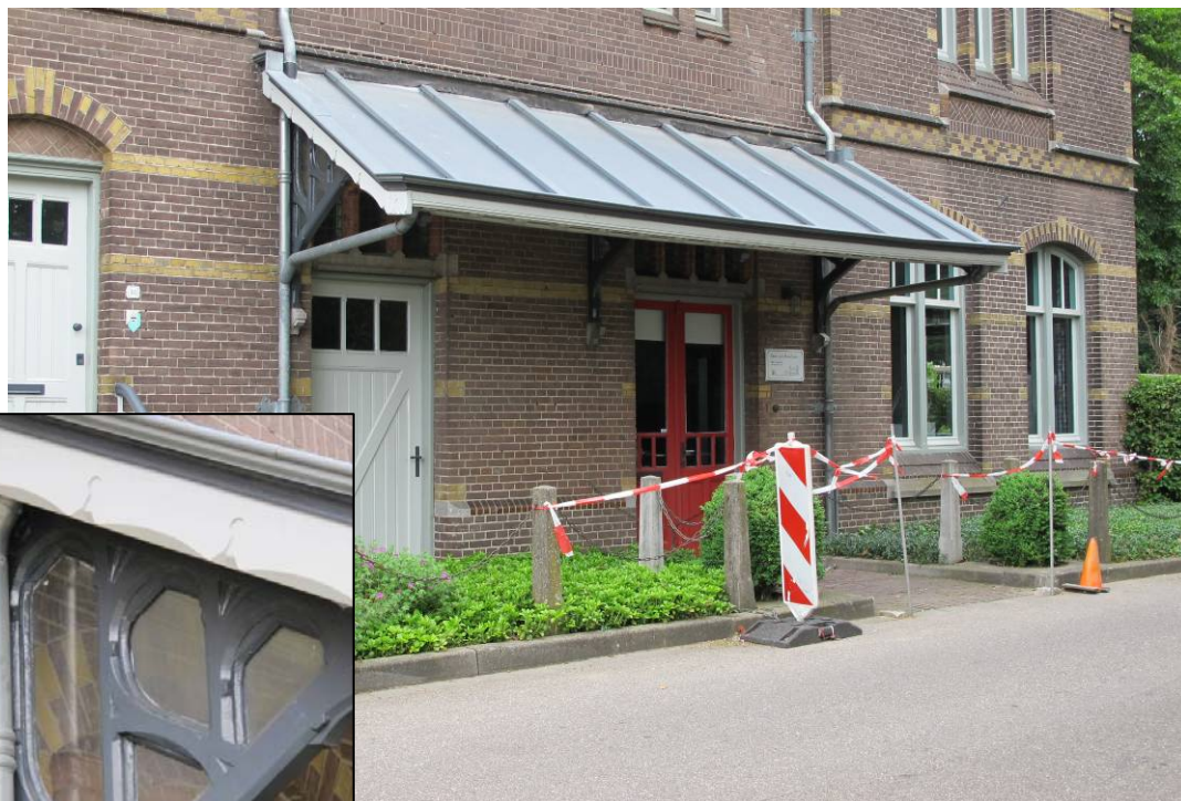
De luifel tegen de oostgevel met links een detail van de bewerkte ondersteuning van deze luifel.
