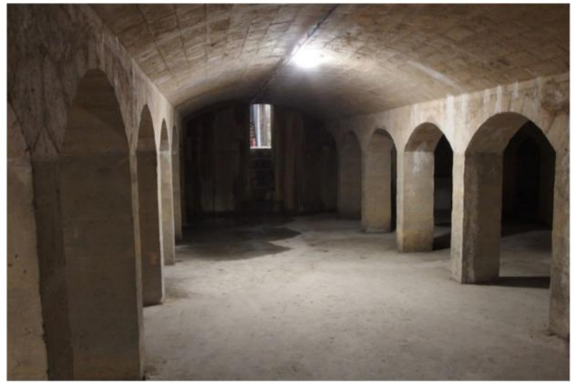
Réservoir souterrain datant de 1845
