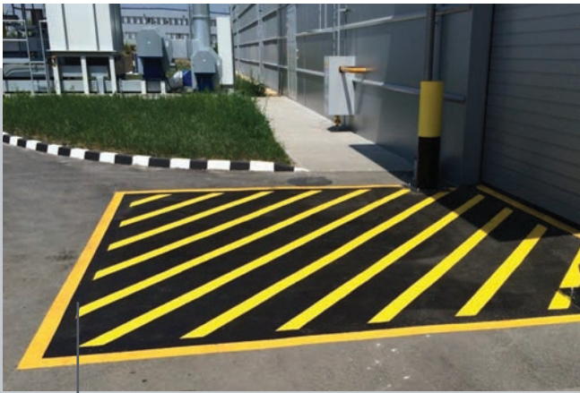
Označavanje vanjske asfaltne površine u distributivnom centru
