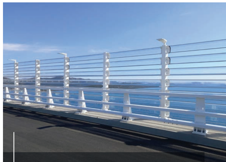
Primjer zaštićene odbojne ograde i nosača vjetrozaštite na Pelješkom mostu
