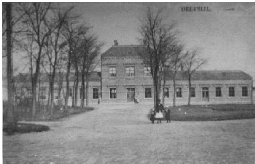
4 Station Delfzijl, geopend 15 juni 1884, foto 1890
