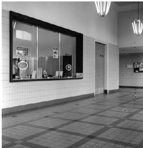
Afb. 5.4.5 Sneek, de gerenoveerde vestibule in 1970. Rechts van de loketten de deuren naar de bagageruimte. Daarachter is de lage hal zichtbaar, die is afgescheiden van de wachtkamer 3e Klasse. Op de voorgrond de plavuizenvloer en aan het plafond de nieuwe lampen.
