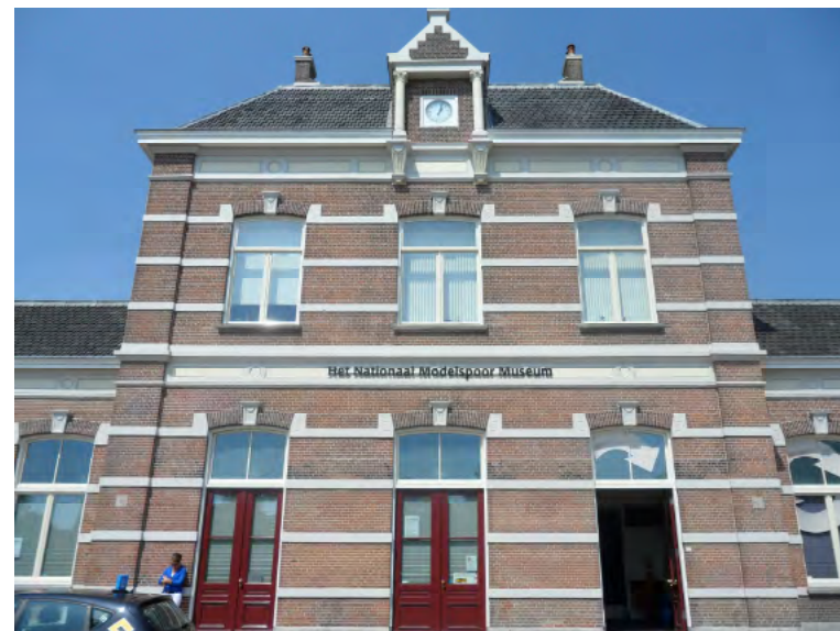
Afb. 2.5.11 Te Sneek staat de naam van het Nationaal Modelspoor Museum centraal op de voorgevel van station. Het gehele gebouw lijkt zo hiervoor bestemd te zijn.
