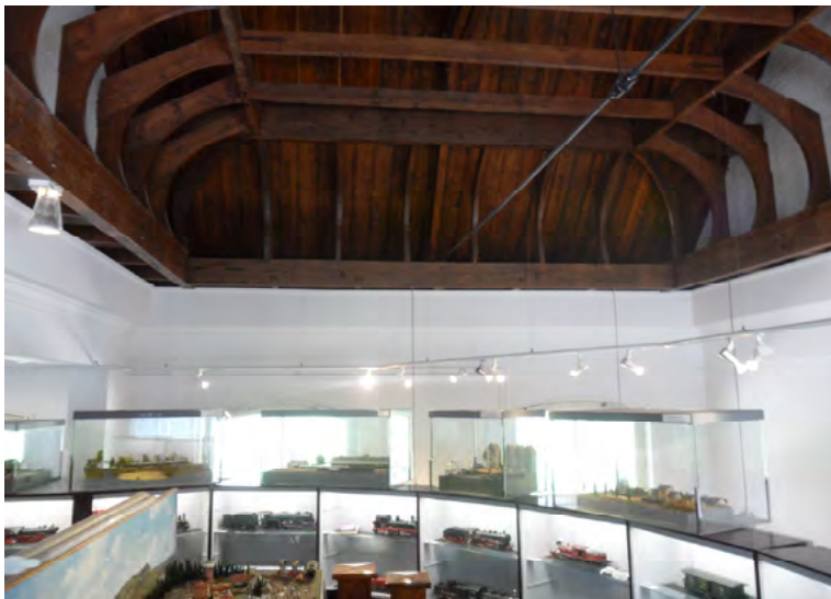
Afb. 2.5.14 De expositieruimte op de ingebouwde entresol. Erboven is de originele houten kapconstructie te zien. De sierafwerking met latwerk is verdwenen.
