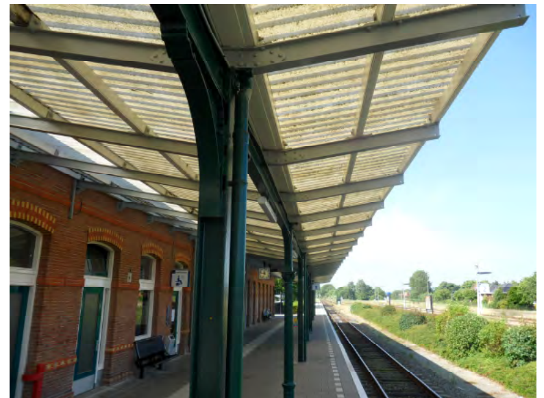
Afb. 5.2.11 De afwijkende zuil van I-profiel onder de perronkap te Delfzijl. De kap is bedekt met lichtdoorlatende golfplaat.
