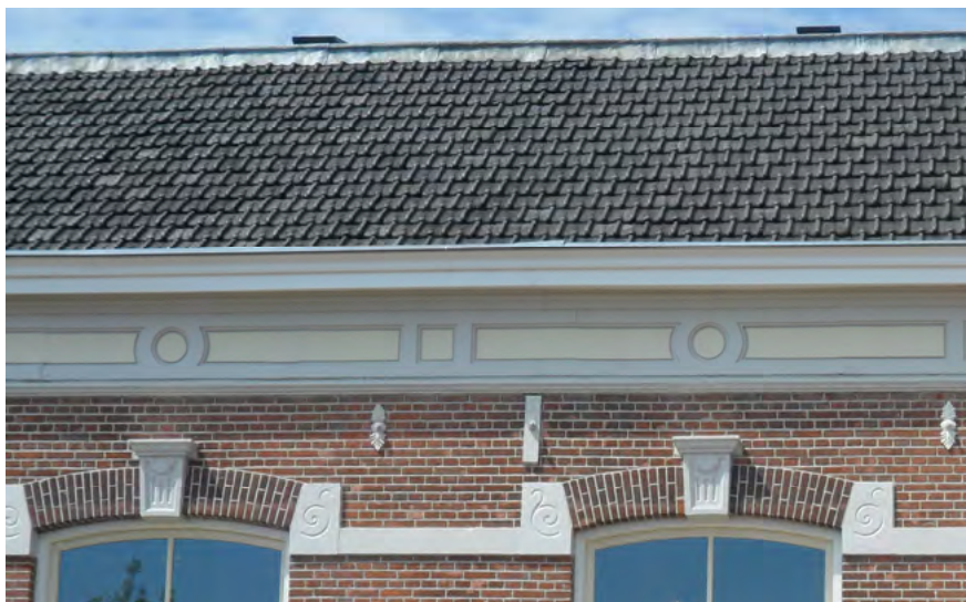
Afb. 5.2.5 Muurafwerking met stucijst op station Sneek.
