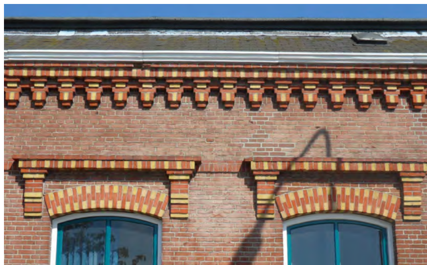
Afb. 5.2.7 Muurafwerking met uitkomend siermetselwerk op station Delfzijl.
