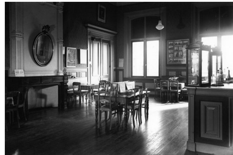
Afb. 5.4.3 Sneek, wachtkamer 1e en 2e Klasse in 1941. Gezien naar de voorgevel. Links-achter de deuren naar de vestibule. Deze ruimte vormt nu het hart van het modelspoor-museum. Foto HUA
