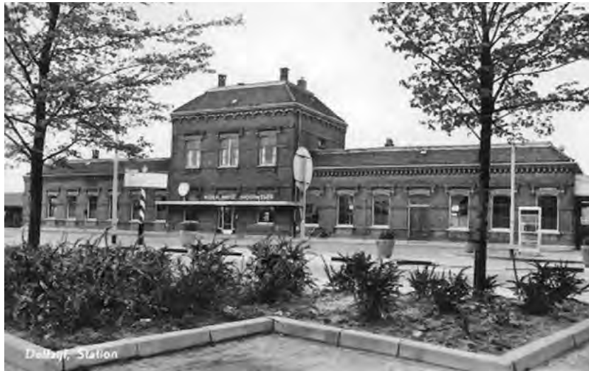
Afb. 2.5.3 Station Delfzijl in 1966. Bij de hoofdentree is een luifel aangebracht. Op het dak van het hoofdvolume zijn de vier schoorstenen nog aanwezig. De stationskap (rechts) heeft nog de verticale houten afwerking. De voorliggende weg is sterk verbreed.
