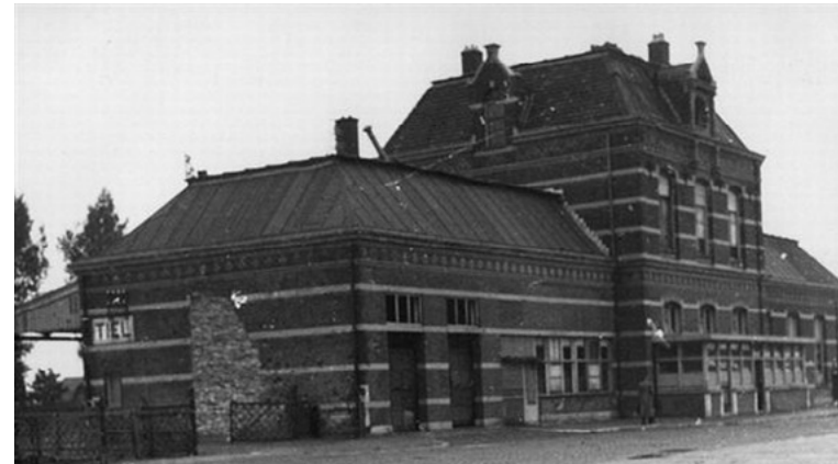
Afb. 5.4.9 De westvleugel van Tiel met pakhuisentrees en vernieuwde ramen in 1945. De vleugel blijkt ernstig beschadigd, maar niet ingestort. Voor de hoofdentree is staat de aanbouw uit de jaren '20.
