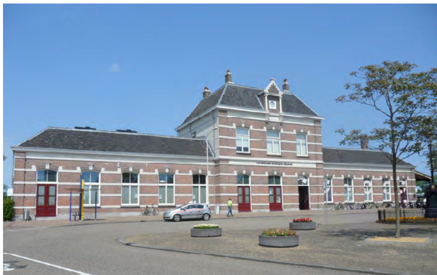
Afb. 5.2.1 Voorgevel met tweelaags hoofdvolume en éénlaags zijvleugels.
