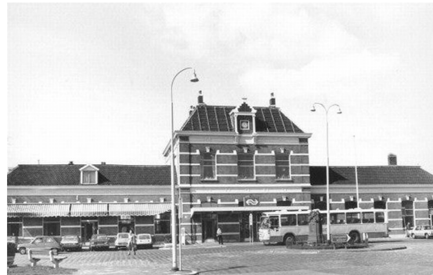
Afb. 5.4.7 Sneek, voorgevel met moderne entrees en luifel. Voor de westvleugel hangen zonneschermen. Op het dak is een dakkapel aangebracht. Middenvoor, op het plein, de voet van de verdwenen originele lantaarn. Ansichtkaart 1980
