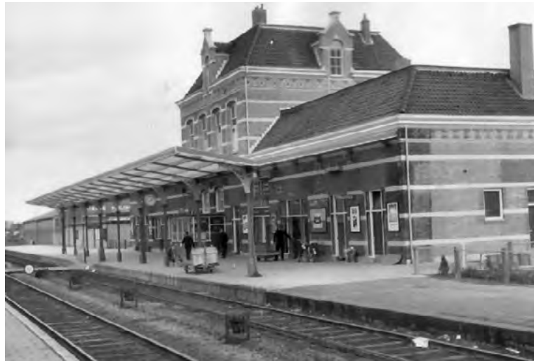
Afb. 5.4.11 De perronzijde van Tiel. Aan het plaatskaartenkantoor is een uitbouw geplaatst. De perronkap is geheel voorzien van lichtdoorlatend materiaal. Foto 1970
