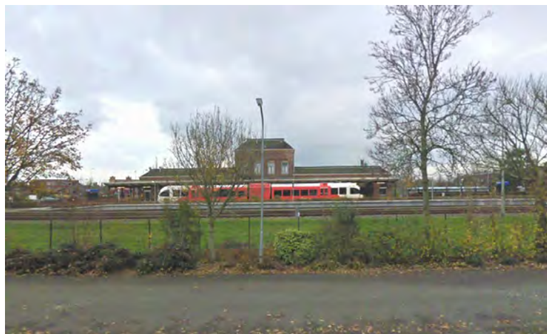
Afb. 3.2.7 Zicht op de perronzijde van station Delfzijl, vanaf de Uitwierderweg in de noordelijke woonwijk. Bron; still uit Google Streetview
