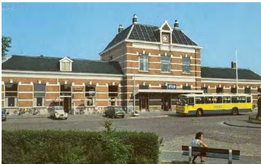
Afb. 2.5.4 Station Sneek in 1970. Voor de hoofdentree is een luifel aangebracht. Op de westvleugel staat een extra dakkapel. In het midden van de westvleugel is een extra entree aangebracht. Aan het gehele gebouw zijn ramen en deuren gemoderniseerd. Voor de hoofdentree is een busstation aangelegd.
