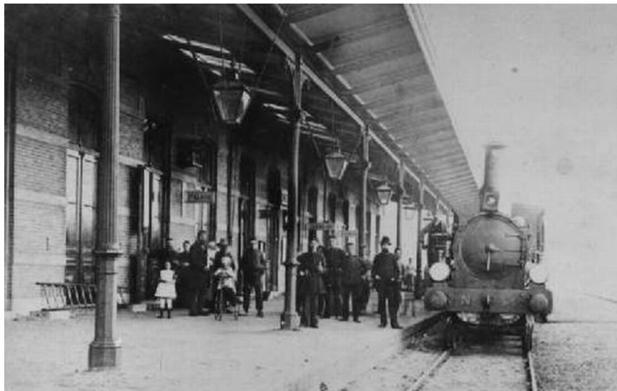
Afb. 5.2.9a De perronkap te Sneek in 1890. Tussen de kolommen van de perronkap hangen lantaarns. In de kap boven het perron zijn lichtdoorlatende platen/ vensters aangebracht.
