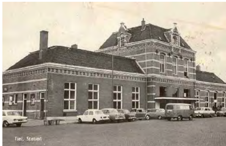
Afb. 5.4.12 De voorzijde van Tiel. Aan de hoofdentree is een luifel bevestigd. De vensters van de westgevel hebben een vlakke afwerking van metselwerk, de vensters van de oostvleugel hebben de historische lichte ronding boven de sponningen. Foto 1960
