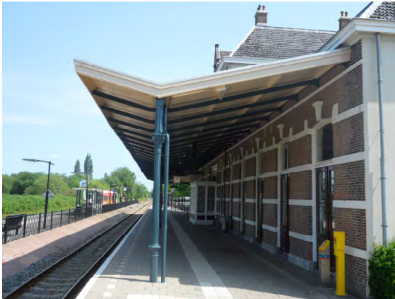
Afb. 5.2.9 Geknikte perronkap op station Sneek, met gietijzeren kolommen. De kap is geheel afgewerkt met witgeschilderd latwerk.
