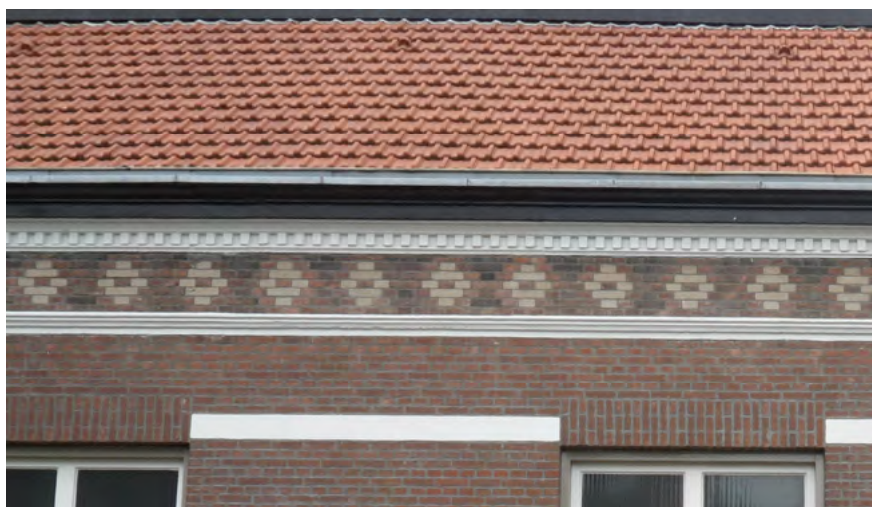
Afb. 5.2.6 Muurafwerking met siermetselwerk en stucranden op station Tiel.
