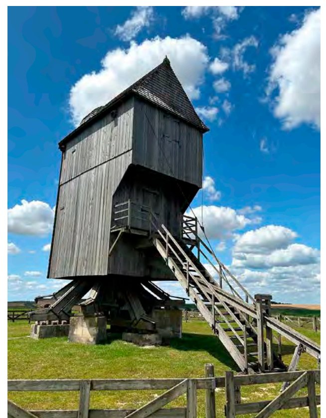
Même sans ses ailes, l'emblématique moulin de Valmy reste accessible aux visites. © Centre historique Valmy 1792
