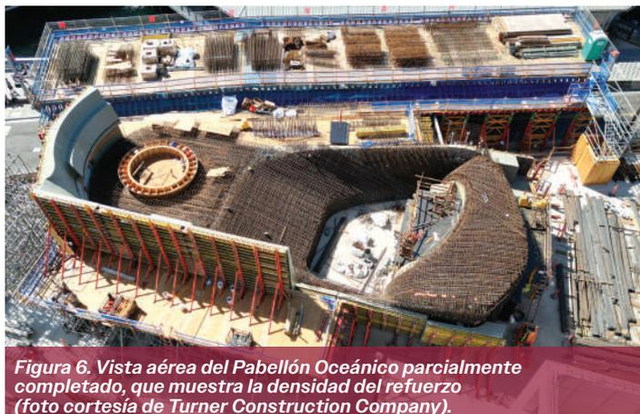
Figura 6. Vista aérea del Pabellón Oceánico parcialmente completado, que muestra la densidad del refuerzo (foto cortesía de Turner Construction Company).
