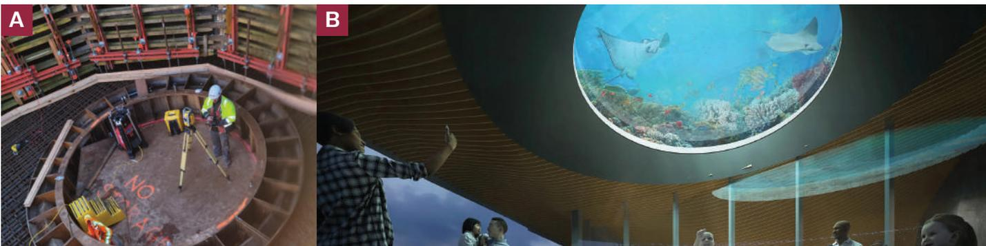
Figura 3. El encofrado para el Oculus, de aproximadamente 6 metros (20 pies) de diámetro, fue diseñado para crear una abertura donde se colocaría la ventana acrílica de observación: (a) el encofrado se construyó en dos mitades y se envió al sitio de trabajo. Después de que los trabajadores lo atornillaron, se colocó en una sola sección (foto cortesía de Turner Construction Company); y (b) renderización arquitectónica del Oculus (imagen cortesía de LMN Architects y Seattle Aquarium).
