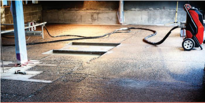
La hidrodemolición deja una superficie de adherencia rugosa y uniforme para el nuevo concreto. También ofrece eliminación selectiva, lo que significa que solo el concreto dañado se selecciona y elimina, mientras que el concreto sano permanece en su lugar
