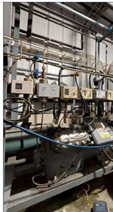
La instalación fue sometida a algunas modificaciones / mejoras, como lo fue la sustitución de la válvula de expansión termostática por una válvula de expansión electrónica.
