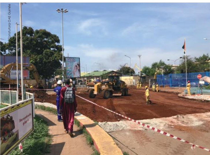
Travaux d'aménagement et de bitumage.
