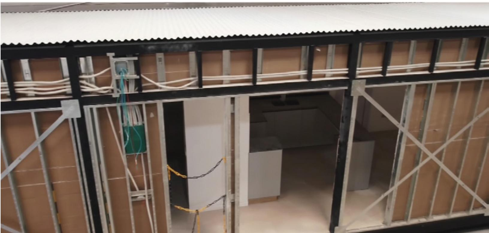
En el marco de la construcción modular e industrializada, las instalaciones hidrosanitarias se caracterizan por estar completamente integradas desde la fase de fabricación, garantizando que el módulo sea funcional desde el momento de su entrega.
