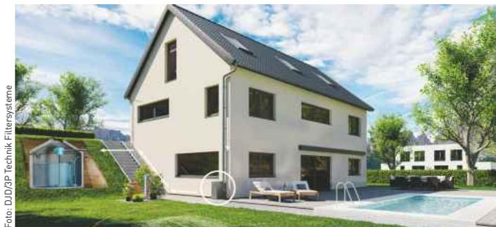
**Eine Funktionsbox, die das Regenwasser von den Fallrohren am Haus aufnimmt, kann es sogar nach oben in einen höher gelegenen Tank pumpen, etwa auf einem terrassierten Hanggrundstück.**
