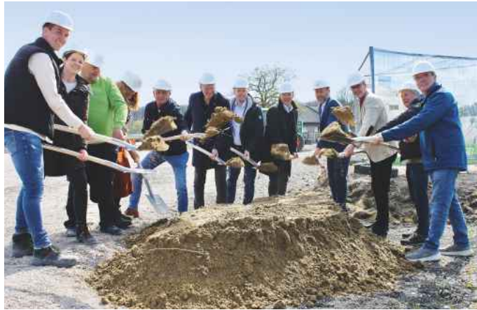
Am 9. April versammelten sich an der Altenberger Straße/Ecke Piggenweg in Steinfurt-Borghorst einige Projektbeteiligte zum symbolischen ersten Spatenstich.
