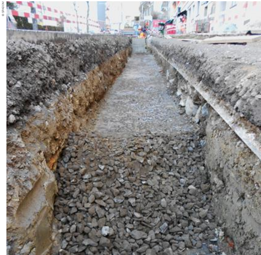
Mélange terre-pierre mis en place.
