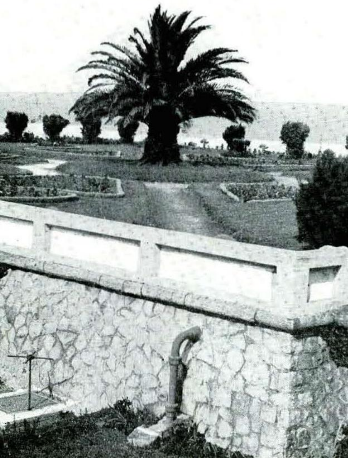
Depósito de agua enterrado, de 4.200 m.c. de capacidad
