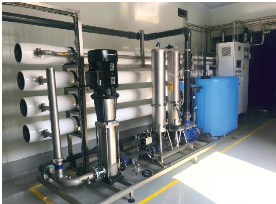
Obr. 1: Jednotka reverzní osmózy typ BWG 5, návrhový průtok 4,5 m 3 /h, 4 moduly.
