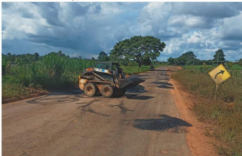
A manutenção asfáltica foi realizada na RO-133, no trecho que liga o município de Vale do Anari a Theobroma
