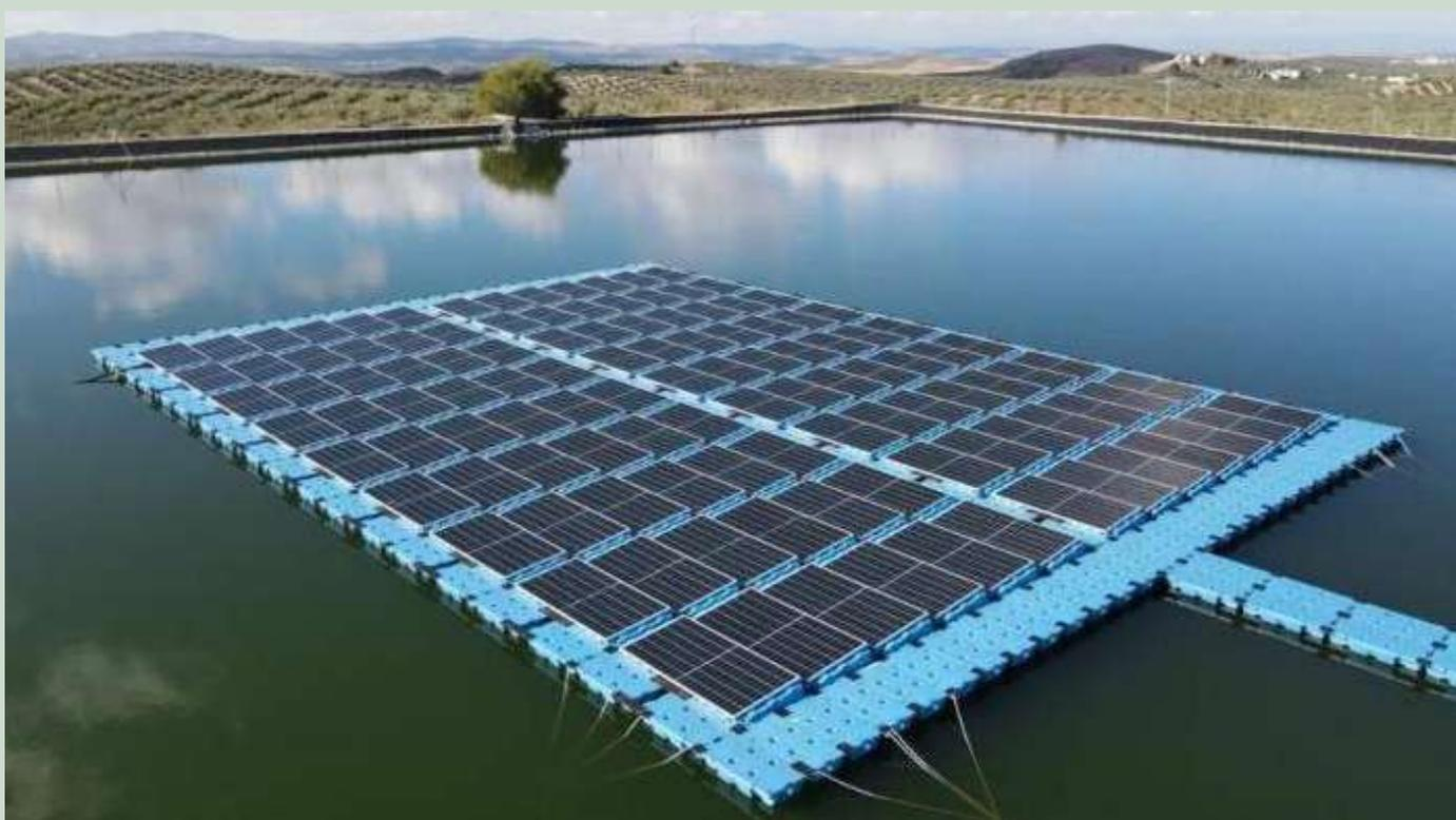
constructor andaluz. Su montaje se está llevando a cabo sobre una balsa de riego recientemente construida en la Finca Conde de Guadiana y se estima que estará acabada en seis meses. La planta cuenta con 1.812 módulos fotovoltaicos monocristalinos de 550 WP y 8 inversores de 100KTL, sumando una potencia de 1MW. Con 6.400 m<sup>2</sup> de superficie fotovoltaica flotante y una inclinación de 5°, esta planta ocupará más superficie que un campo de fútbol normal.
