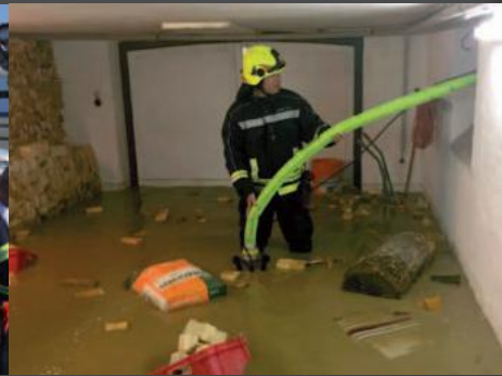
12. Juni 2018: Überflutungen, Nähe Andorfer Ortszentrum
