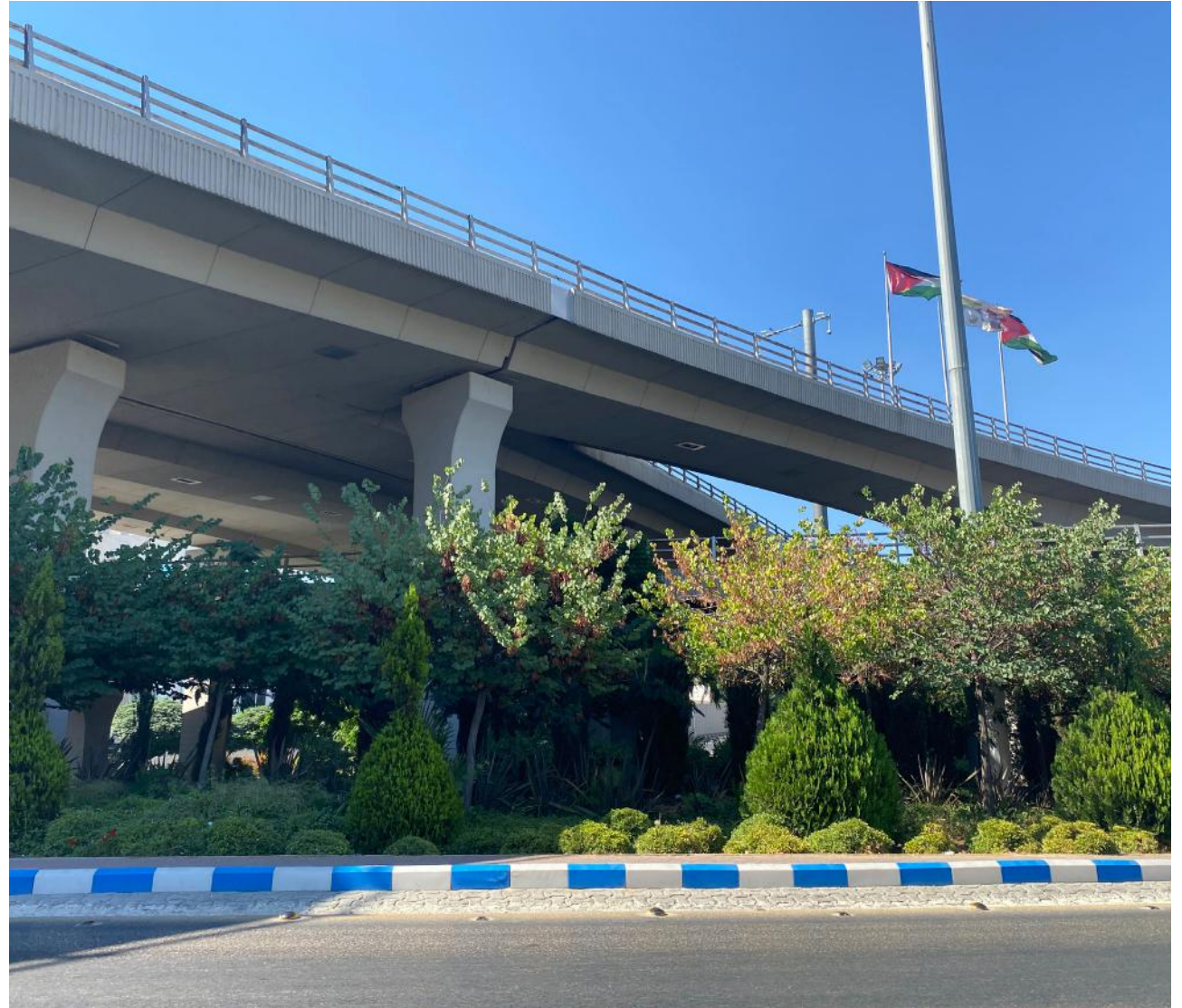
إن الفضاءات التي تقع تحت الجسور (في هذه الحالة، تقاطع مشروع العبدلي في مدينة عمان) يمكن أن تكون أيضاً جزءاً من شبكة فضاءات عامة
