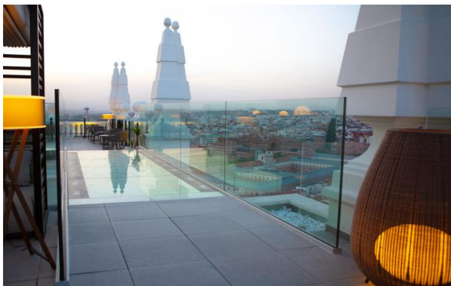
Barandillas laminadas con EVALAM VISUAL y pasarela laminada con AB-AR.
