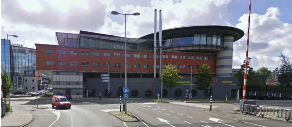
Centrale verkeersleidingsgebouw in Amsterdam, 1995
