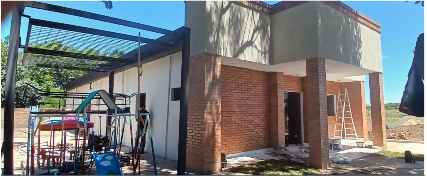
Avances de la construcción del Juzgado de Paz de Villalbín
