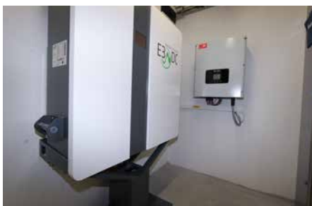
Speichersystem S10 von E3/DC und zusätzlicher SolarEdge Wechselrichter
