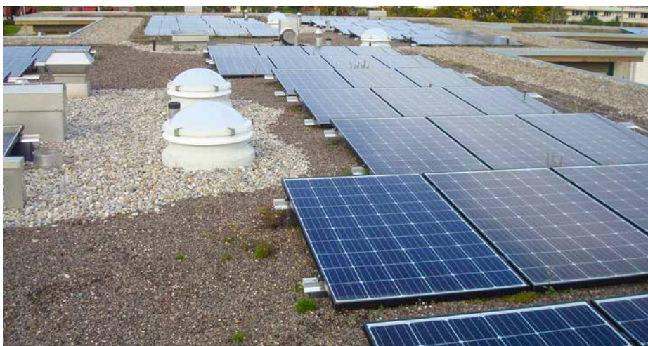
Jeweils 91 Trina Solar Panel TSM 290 mit einer Gesamtfläche von 148 m 2 zieren die Dächer der sechs Wohneinheiten.
