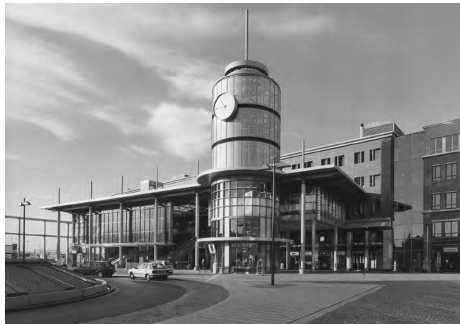
Combibouw: station 's-Hertogenbosch, R. Steenhuis 1998 (bron: Douma, 1998).
