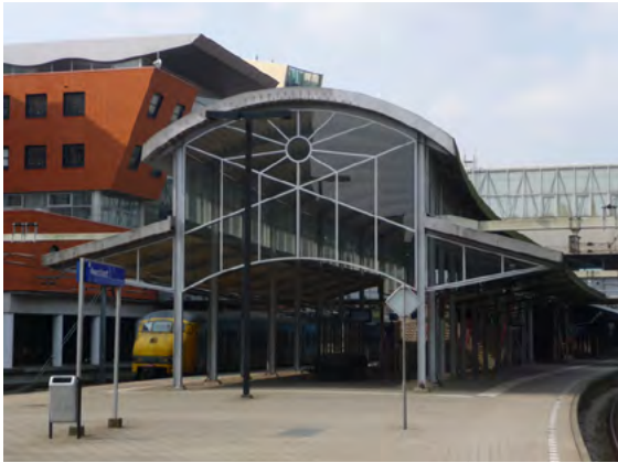
Toegevoegde overkapping oostelijke deel perron 2.
