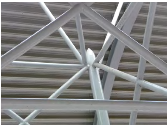
Details kapconstructie perron 3.
