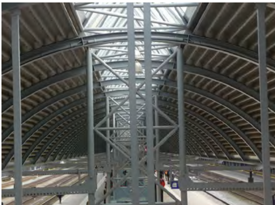
Overzicht, constructie en lichtstraat overkapping perron 3.
