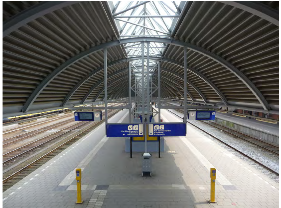
Overzicht perron 3 en overkapping.
