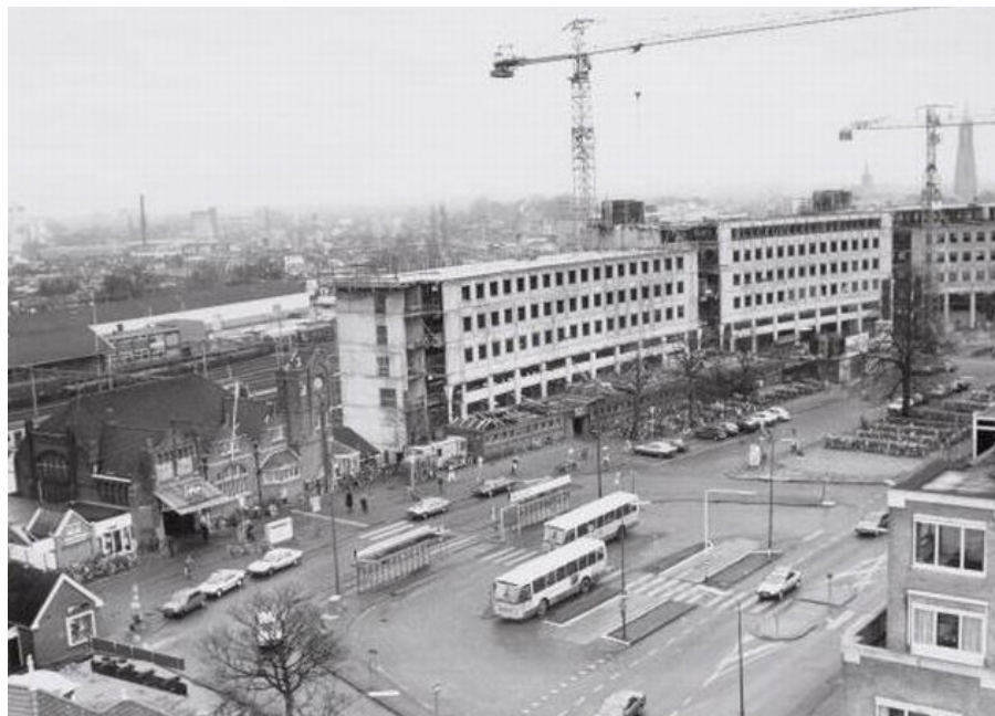
Gefaseerde uitvoering: links het oude station en rechts de eerste kantoorvleugel in aanbouw omstreeks 1988-1989 (bron: stationsweb.nl).
