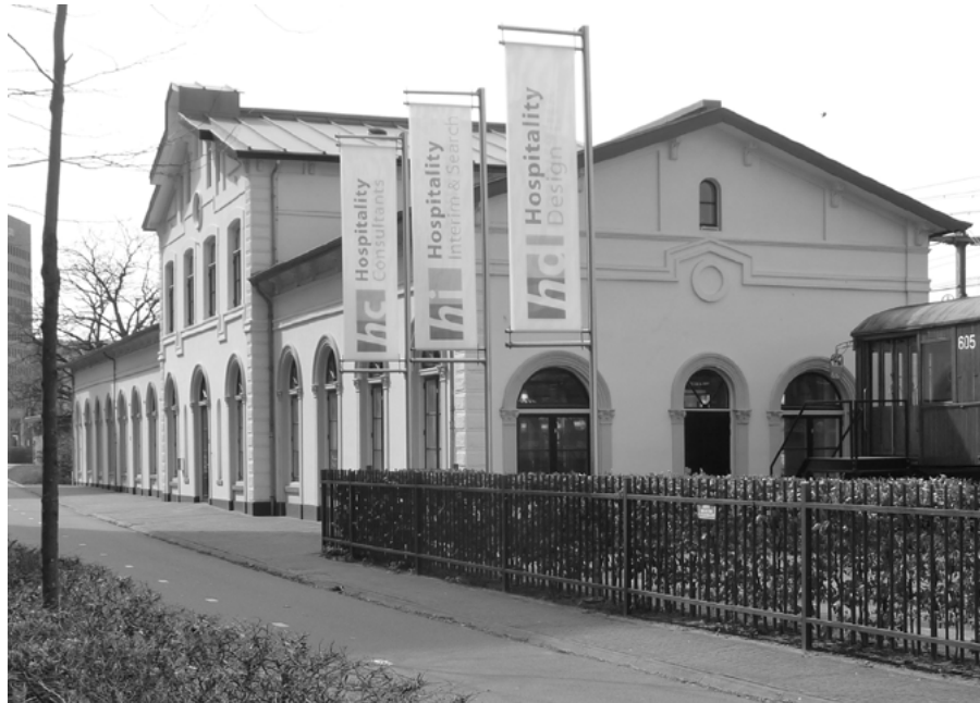
Voormalig station Amersfoort NCSM uit 1863 / 1875 aan het Smallepad.
