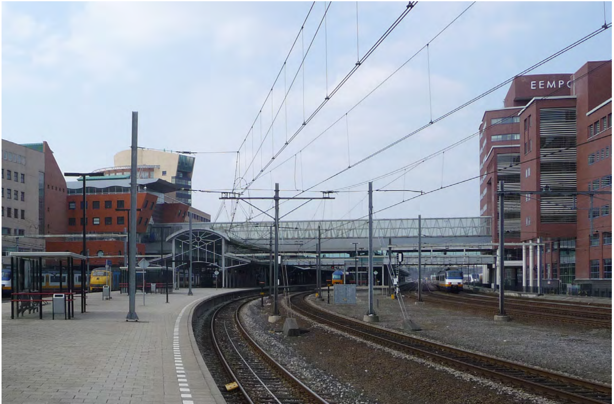
Zicht vanaf het tweede perron in westelijke richting op het station. Goed zichtbaar is het hoogteverschil tussen de perrons en de passerelle. De passerelle sluit links bij de oranje gevels gelijkvloers aan op het niveau van de binnenstad (buiten beeld). Ten opzichte daarvan liggen de perrons en sporen dus verdiept.
