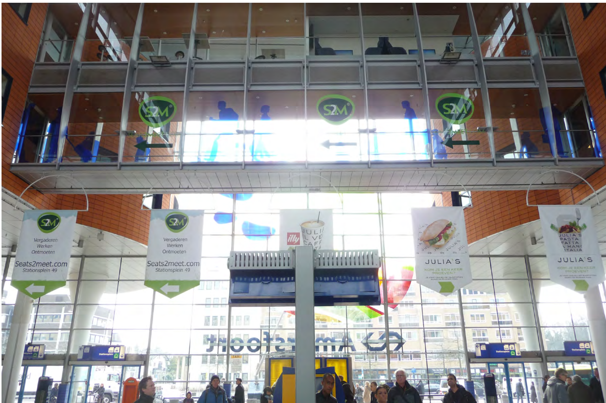
Opslag, beplakte ruiten en reclamebanieren zetten het zicht naar de glazen voorgevel dicht. De transparantie gaat verloren.
