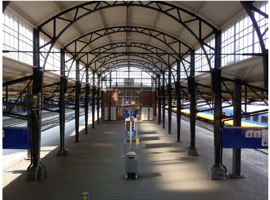
Kap en geïntegreerde bebouwing op perron 2.
