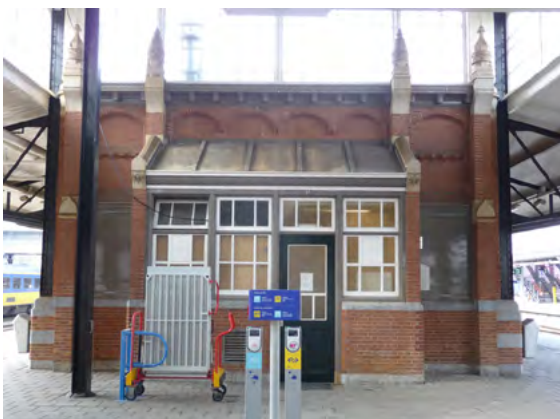
Overzicht en details perronbebauwing.
