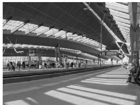
Station Amsterdam Bijlmer ArenA 2006 (bron: Douma, 1998).
