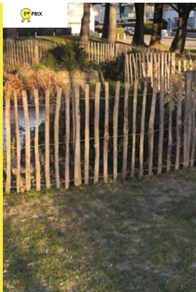
Assemblage par double torsion des fils de fer galvanisés
