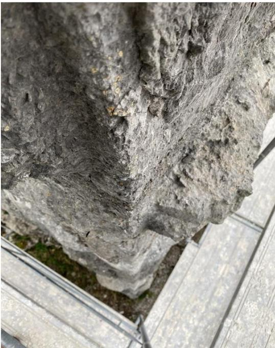
Während die Werkstücke für Fenster- und Türgewände in lokalem Sandstein sehr sorgfältig von Werkmeistern gehauen wurden, zeigt das Steinmaterial des bewusst ungeschlachten Megalithmauerwerks keine Bearbeitungsspuren.
