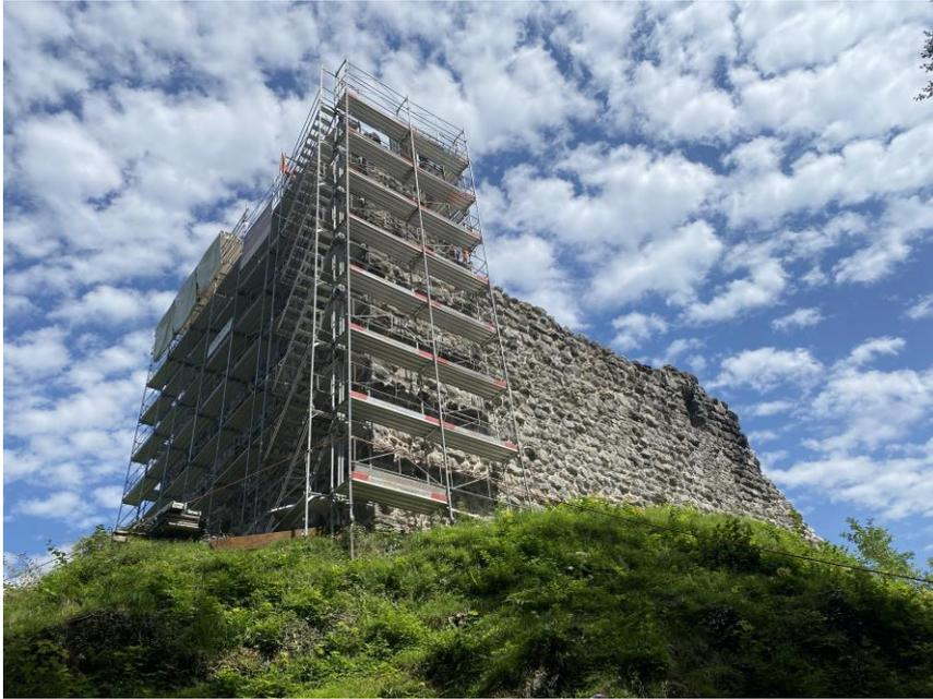
Hauptarbeit der Sicherung 2023 war die 2.4 Meter breite feindseitige Mauer 1 mit ihrem Megalithmauerwerk. Die tief ausgewitterten Fugen wurden in mehreren Aufträgen mit Zwicksteinen ausgefugt. Kein heute Lebender wird erleben, dass sich hier wieder Steine lösen.
