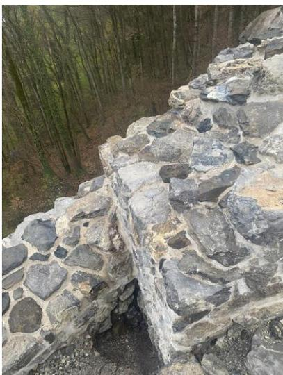
Die Schnittstelle der südlichen Ecke des Donjons mit der hier stumpf anstossenden Zwingermauer, die nur die halbe Mauerstärke der Donjonmauer aufweist. Am unteren Bildrand der Stoss der eingefügten Südostfront des Donjons.
