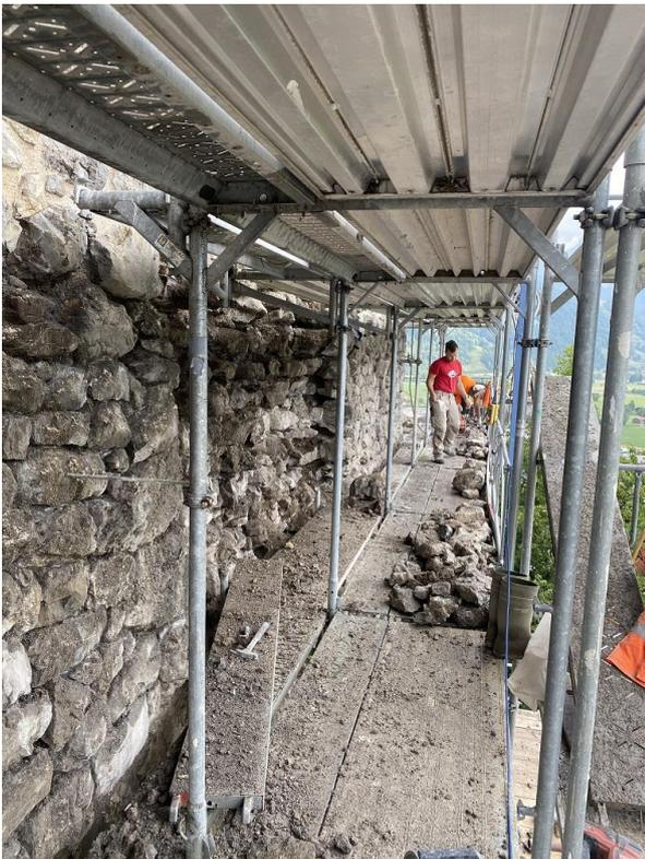
Inneres Mauerhaupt vor der Reinigung. In der Bildmitte das vor 1930 abgeplatzte innere Mauerhaupt, das nur teilweise wieder aufgebaut wurde. Um möglichst nahe am Originalzustand zu bleiben, gelang es gut, die aufgebrochene Partie im Zerfallszustand dauerhaft zu sichern.
