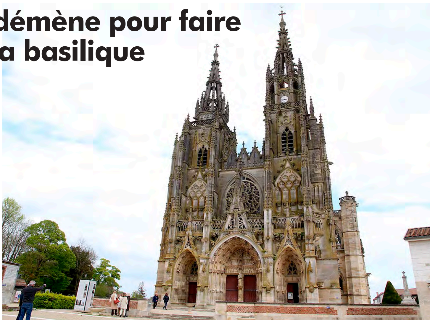
La troisième tranche de la restauration de Notre-Dame de L'Épine pourrait démarrer en 2025. © l'Hebdo du Vendredi
