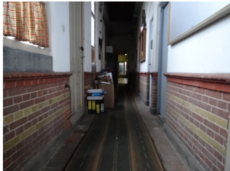
Afb. 5.32 De baksteenvloer uit 1886 in de gang in de noordvleugel, met daarover een oude looper. De afwerking van de wanden dateert eveneens uit de bouwperiode.
