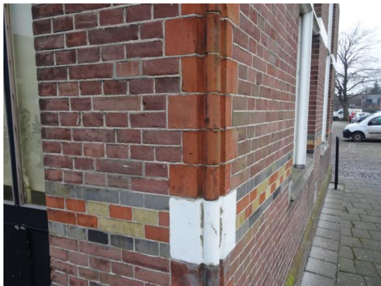
Afb. 5.10 De fraai geprofileerde hoekbanden in rode verblendsteen. De horizontale band van siermetselwerk is op de hoekkruising als speklaag afgewerkt.
