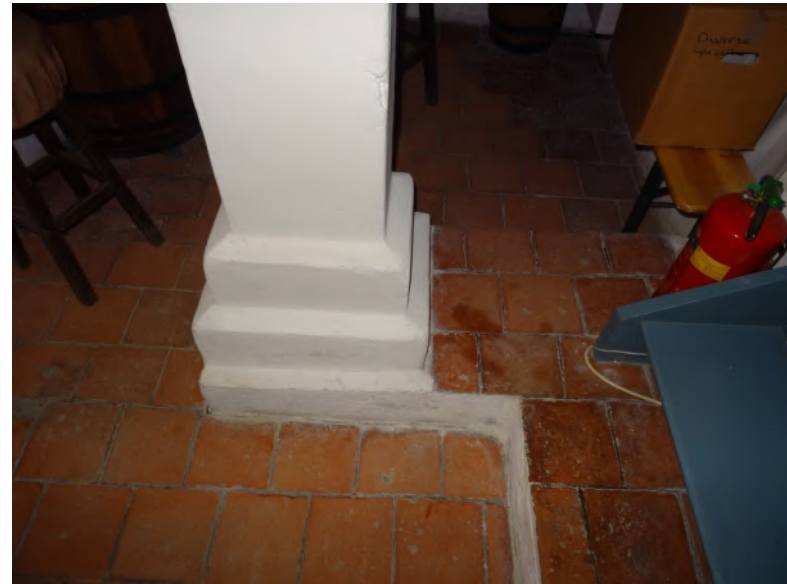
Afb. 5.37 De originele tegelvloer van estrikken in de kelder.
