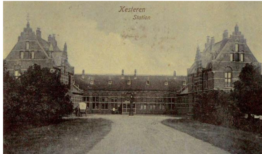
Afb. 2.10 A De pleinzijde van het station in 1905, met de optisch symmetrische opbouw van het complex. Voor de bescheiden entree is op een onbekend moment tussen 1885 en 1905 een tochtportaal gebouwd. Ansichtkaart, 1905, coll. HUA, cat.nr 165223.
