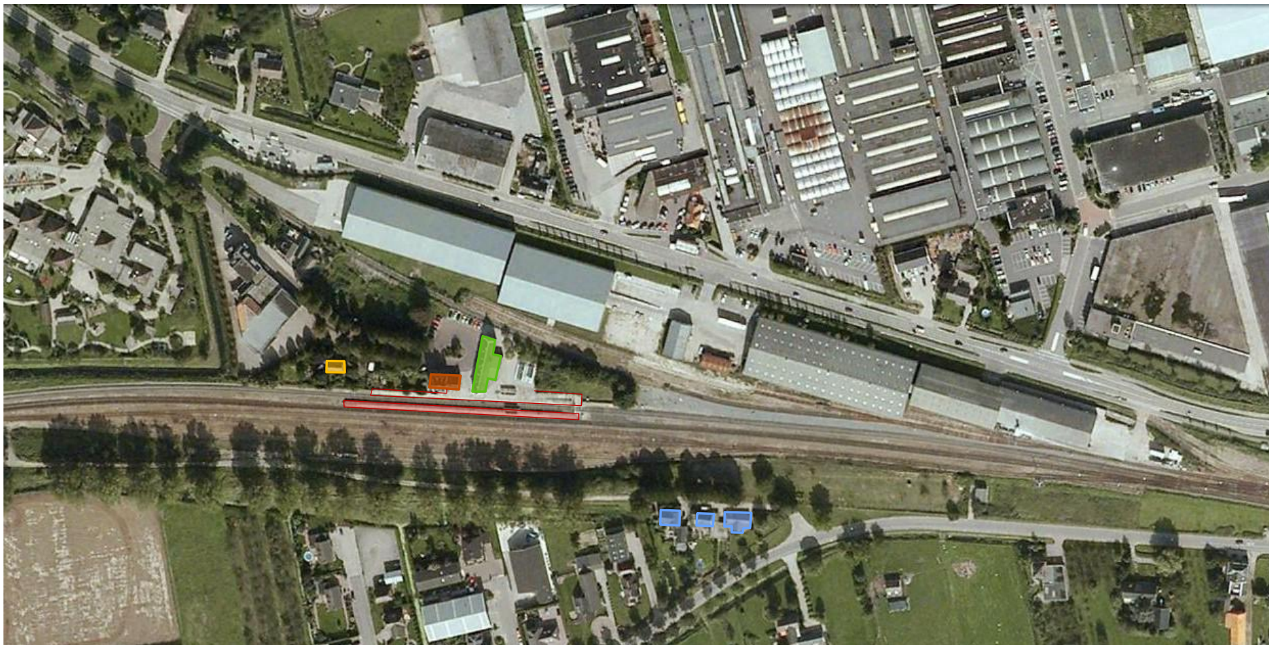
Afb. 4.3 Het actuele emplacement op een luchtfoto uit circa 2005. Centraal ligt het stationscomplex; het pleinebouw met aanbouw (groen) en het zuidelijk dienstgebouw (oranje). Ten westen van het complex staat de voormalige dienstwoning. De zuidelijke perrongrens en het zuidelijk eilandperron zijn aangegeven met rood. Hieraan is zichtbaar dat de perronlengtes in de afgelopen halve eeuw zijn ingekort aan de heersende ruimtebehoefte. Aan de noordzijde ligt het industrie- en bedrijventerrein Het Panhuis. Aan de zuidzijde liggen achter de grensbeplanting drie voormalige dienstwoningen (lichtblauw). Bron; Google earth.
