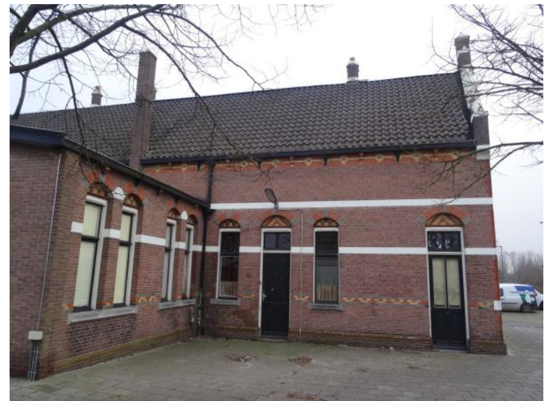
Afb. 5.9 Het oostelijke dakvlak is gedekt met gesmoorde holle pannen.
