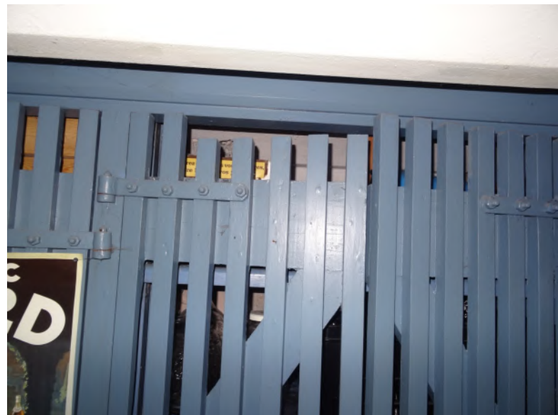
Afb. 5.38 De originele voorraadkast van latwerk in de kelder.
