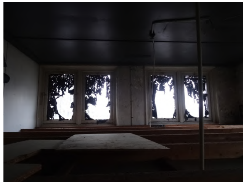
Afb. 5.29 Het oude plafond in de meest oostelijke ruimte, met eenvoudige afwerking, boven het verlaagde plafond.
