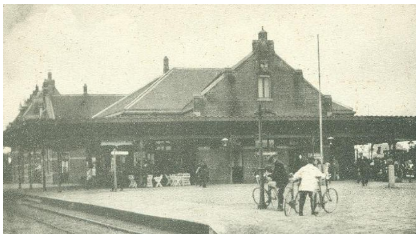
Afb. 2.7 Het perrongebouw, gezien vanuit het zuidoosten. Links onder de perronkap is de unieke terrasrichting zichtbaar, voor de wachtkamer 1e en 2e Klasse. Ongedateerde Ansichtkaart, vermoedelijk begin jaren dertig.
