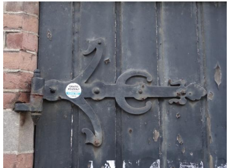
Afb. 5.28 Origineel beslag, op de rechterdeur in de oostgevel van dienstaanbouw. Deze details dragen sterk bij aan de aantrekkelijke uitstraling van het gebouw.
