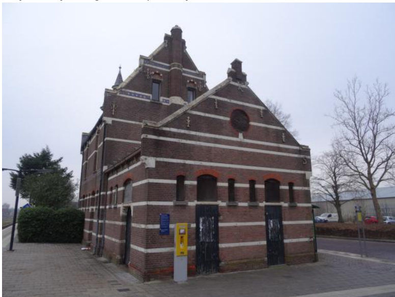
Afb. 5.26 De oostgevel van dienstaanbouw, met originele deuren en dichtgetimmerde bovenramen. Het complex heeft hierdoor aan de deze zijde een verlaten en verwaarloosde uitstraling.
