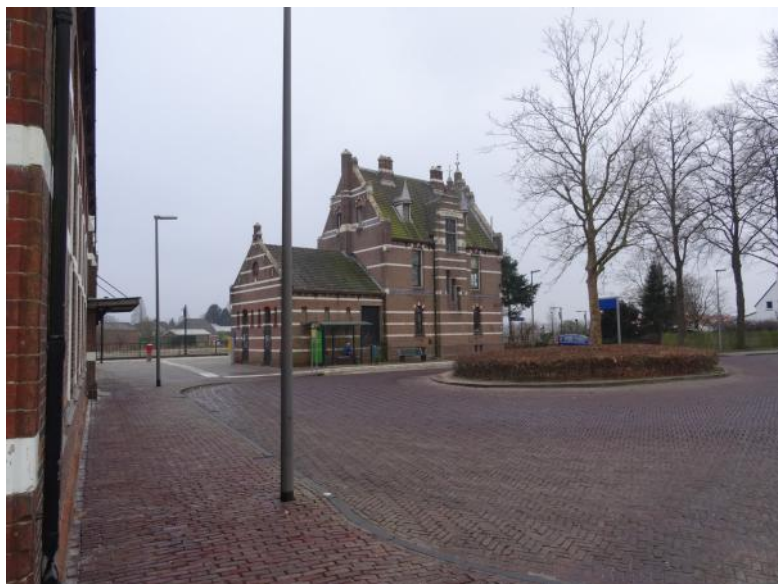
Afb. 4.5 Het stationsplein met het dienstgebouw aan de zuidzijde, gezien vanaf de noordhoek van het stationsgebouw. Links ligt de doorgang naar het perron. Voor de dienstvleugel staat de bushalte.
