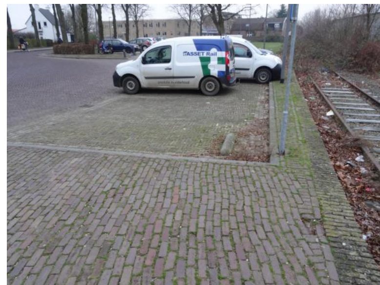
Afb. 4.7 De overgang tussen het rommelig afgewerkte stationsplein en het verwilderde restant van de sporen 1 en 2.
