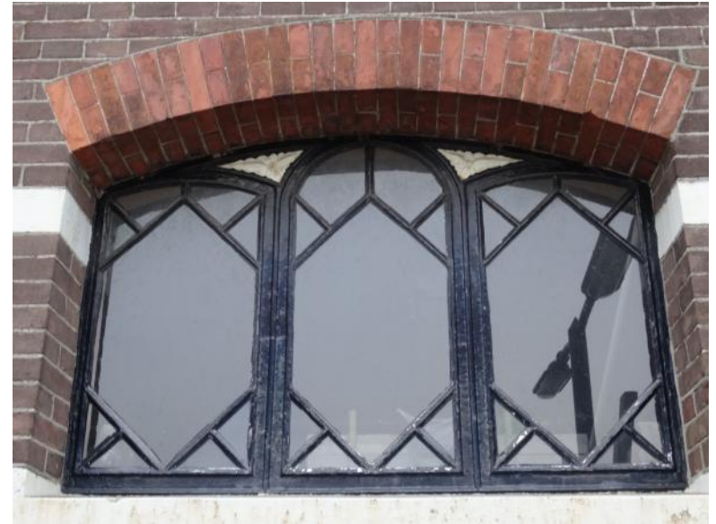
Afb. 5.23 De gietijzeren ramen in de dienstruimten.
