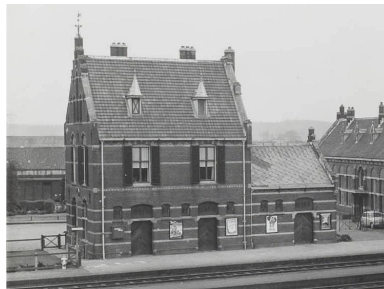
Afb. 5.16 Naoorlogse dakbedekking met pannen op de woning en leien op de dienstaanbouw. Foto 05-12-1955, coll. Spoorwegmuseum, inv.nr 11169.
