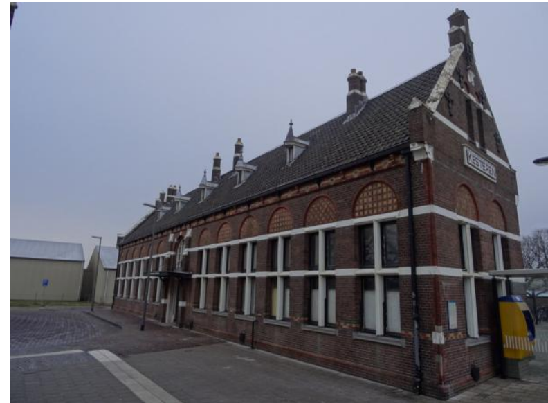
Afb. 5.8 Het westelijk dakvlak is gedekt met Tuile du Nordpannen en onderbroken door zeven dakkapellen. De voorgevel in gedeeld in dertien traveeën.
