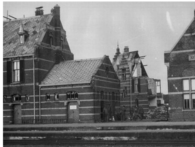
Afb. 5.15 De daken van het dienstgebouw, in ruitvorm gedekt met leien. Foto 1945, coll. HUA, cat.nr 158071.
