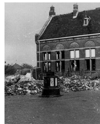
Afb. B3.6 De voet van de verwoeste lantaarn, met op de achtergrond het ingestorte dienstgebouw en het beschadigde pleingebouw. Foto 1945, coll. HUA, ca.tnr 158067.
