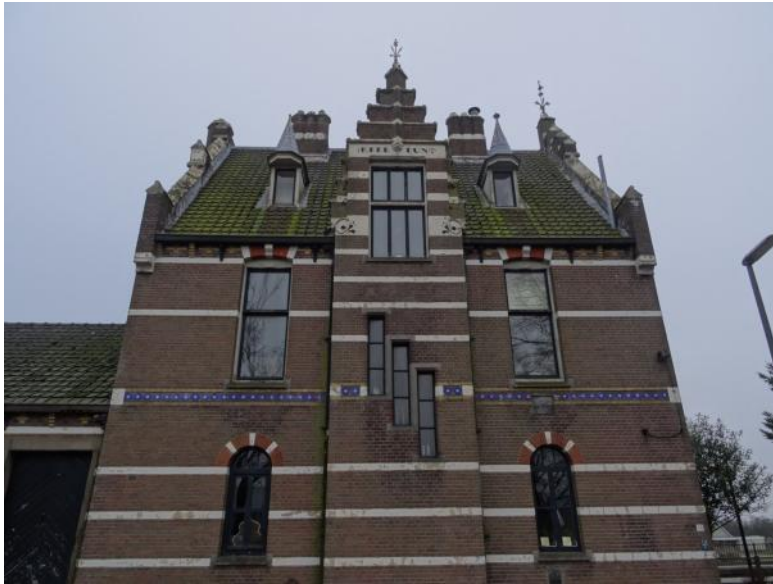
Afb. 5.21 De tegelband op de overgang van begane grond naar verdieping. Op de hoeken is de band afgewerkt met witte blokken. Opvallend in de pleingevel zijn de drie ramen van het trappenhuis.
