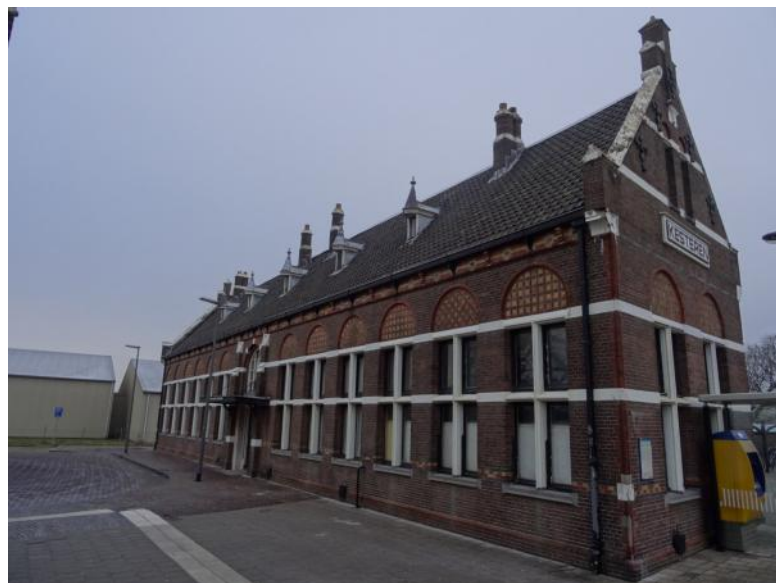
Afb. 4.13 De pleingevel van het stationsgebouw, gezien vanuit de doorgang van perron naar stationsplein. De verschillende reizigersvoorzieningen zijn rechts tegen de gebouwgevel geplaatst. Het aanzicht van het gebouw vanaf het perron wordt hierdoor ontsierd.
