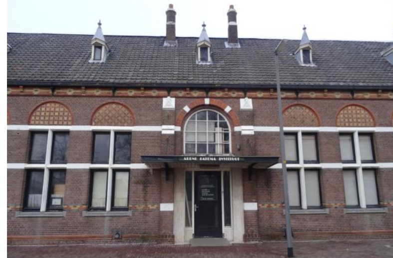
Afb. 5.14 De actuele, niet in gebruik zijnde, entree aan het stationsplein, zoals deze is gemoderniseerd rond 1964. Binnen de oorspronkelijke kozijnen zijn toen eenruits bovenramen en een nieuwe entreedeur aangebracht.
