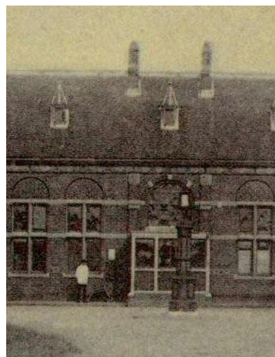
Afb. B3.5 In 1905 staat voor het pleingebouw van het station een forse, ornamentale lantaarn. Detail van Ansichtkaart uit 1905, coll. HUA, cat.nr 165223.
