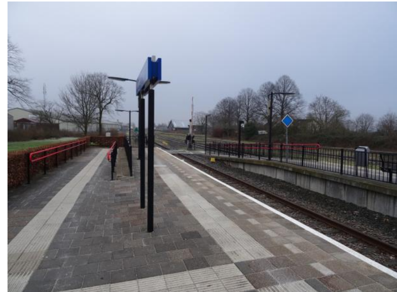
Afb. 4.10 De overweg tussen perron 3 (links) en het eilandperron 4. Rechtsachter staan bomen op de grens van het emplacement. Daarachter staan drie vroegere dienstwoningen.
