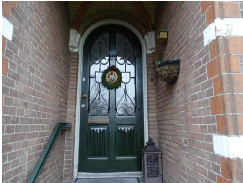
Afb. 5.25 De deur naar de woning. Het houtwerk is origineel, het glas-in-lood is rond 1990 hersteld naar voorbeeld van de bestekstekening uit 1886. In variatie hierop zijn de raamluikjes daarbij vervangen door wapenschildjes.
