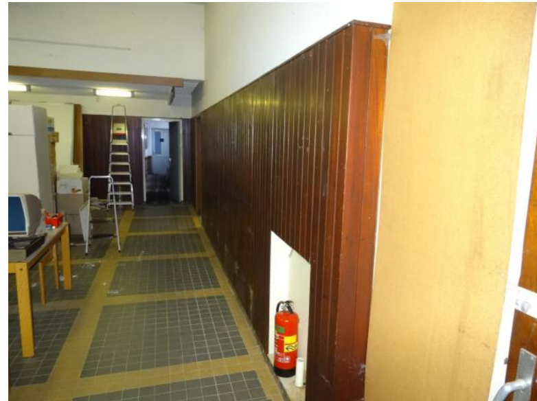
Afb. 5.31 De jaren zestig tegelvloer in de zuidvleugel. Gezien vanaf het plaatskaartenkantoor naar de gang in de noordvleugel. Rechts de jaren zestig schroten-afwerking van de wanden.
