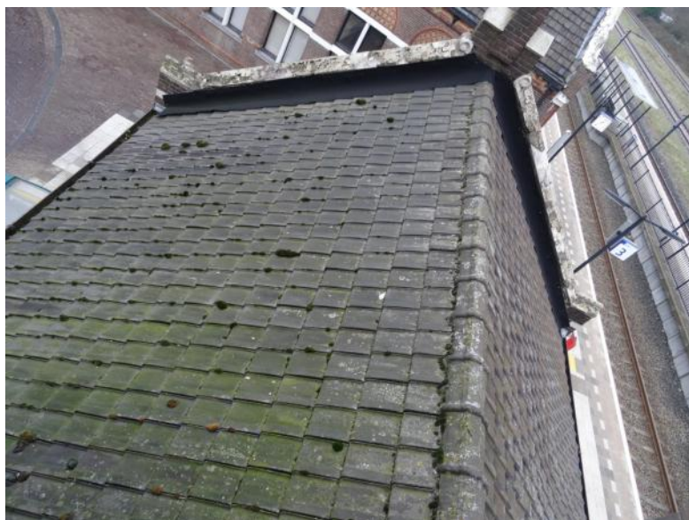
Afb. 5.17 De dakbedekking met Tuile du Nordpannen op de dienstaanbouw. Langs de topgevel is zichtbaar dat de verdwenen loodslabben zijn vervangen door EPDM.
