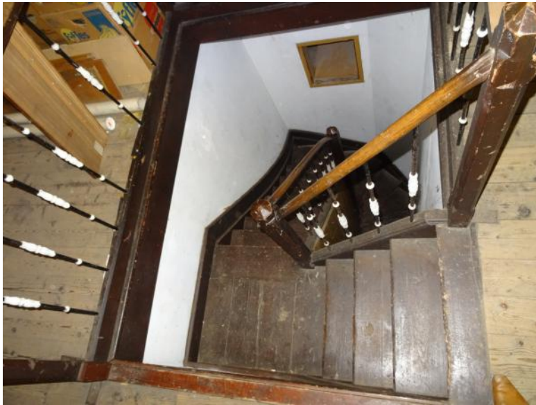
Afb. 5.34 Het originele trappenhuis vanaf de zolder naar de oude gang.
