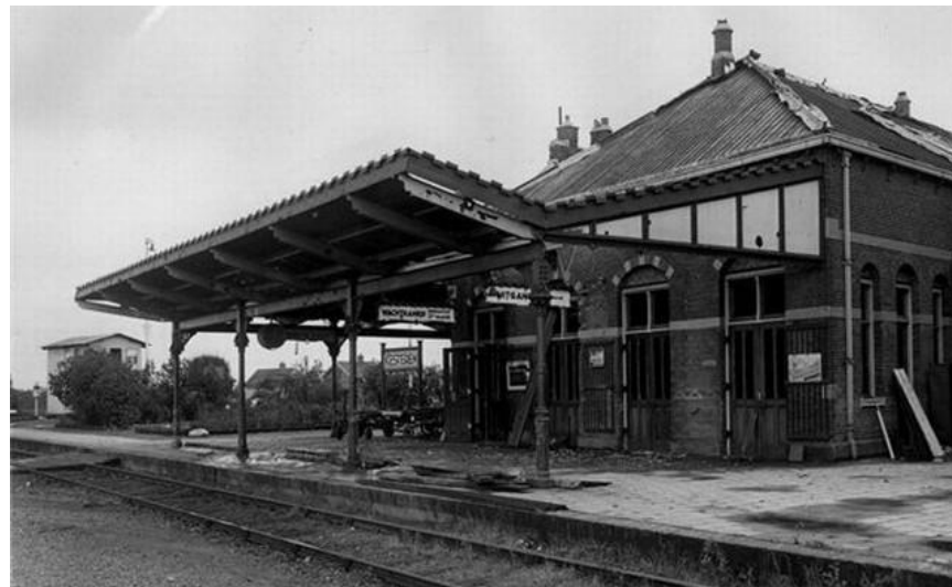
Afb. B3.8 Oorlogsschade aan het perrongebouw en de perronkap. Foto 1945, coll. HUA, cat.nr 158070.
