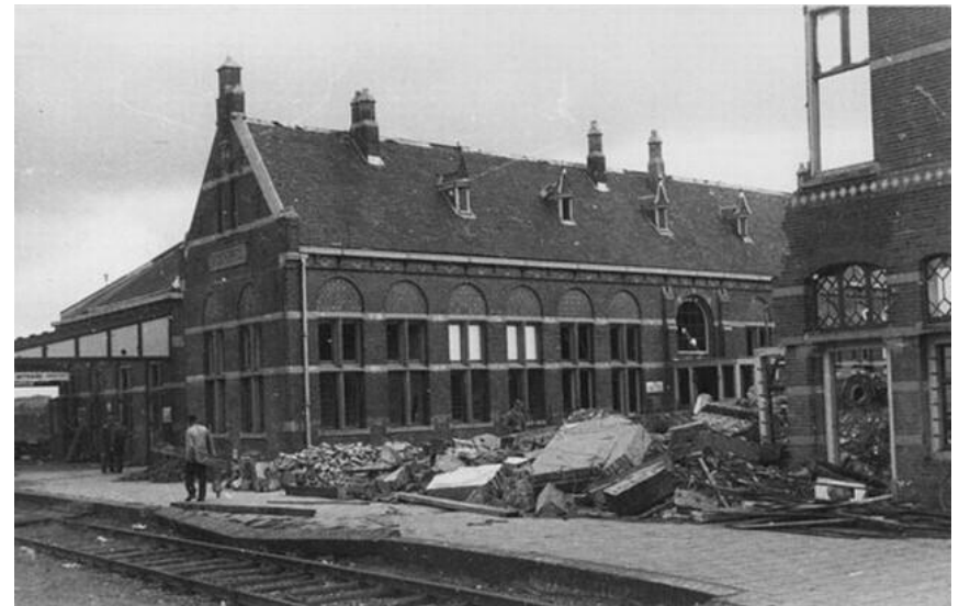
Afb. 2.13 Oorlogsschade aan het stationscomplex; over het ingestorte noordelijke dienstgebouw is er zicht op het beschadigde stationsgebouw. Foto 1945, coll. HUA, cat.nr 158068.
