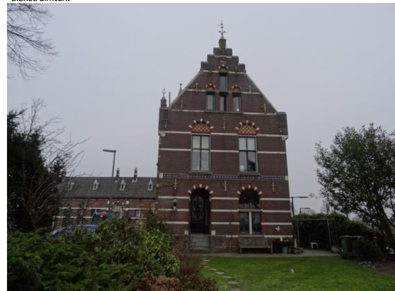
Afb. 5.19 De hoge noordgevel. Het metselwerk wordt doorsneden door speklagen. In symmetrisch patroon zijn muurankers langs de gevel bevestigd. De topgevel en gevelpunt aan de pleinzijde worden bekroond met een smeedijzeren ornament.
