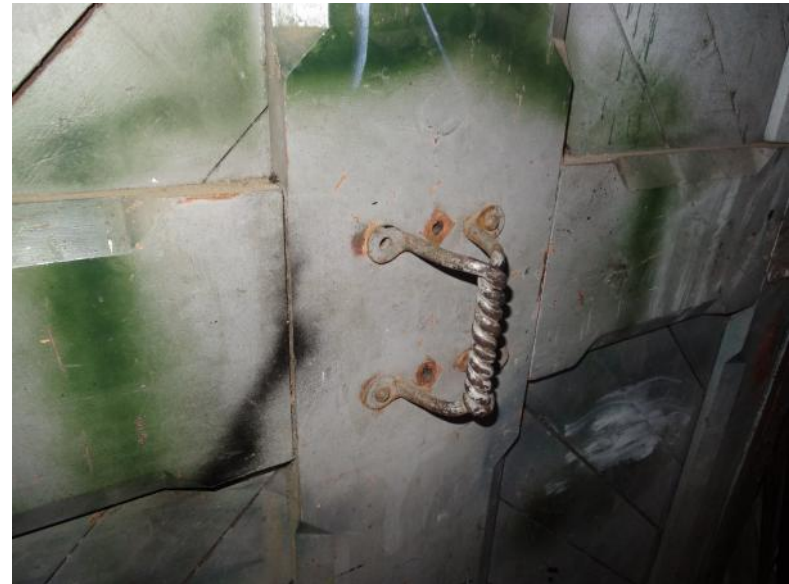
Afb. 5.27 Originele deurgreep aan de schuifdeur naar het perron, in de zuidwestelijke dienstruimte.
