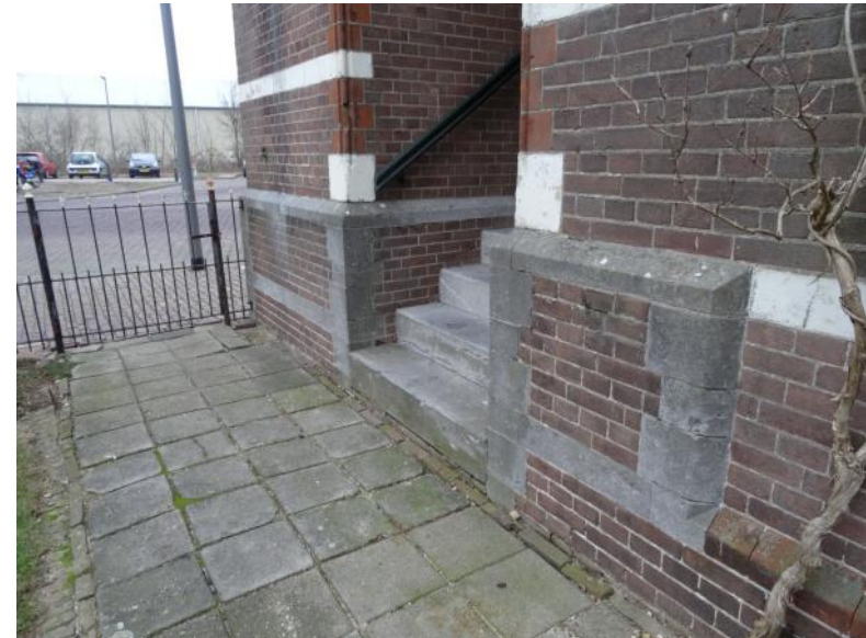
Afb. 5.18 De twee plintafwerkingen aan het dienstgebouw. Links de hoge plint met hardsteenrand langs de woningdelen, rechts de lage plint met verblendsteenrand langs de dienstruimten.
