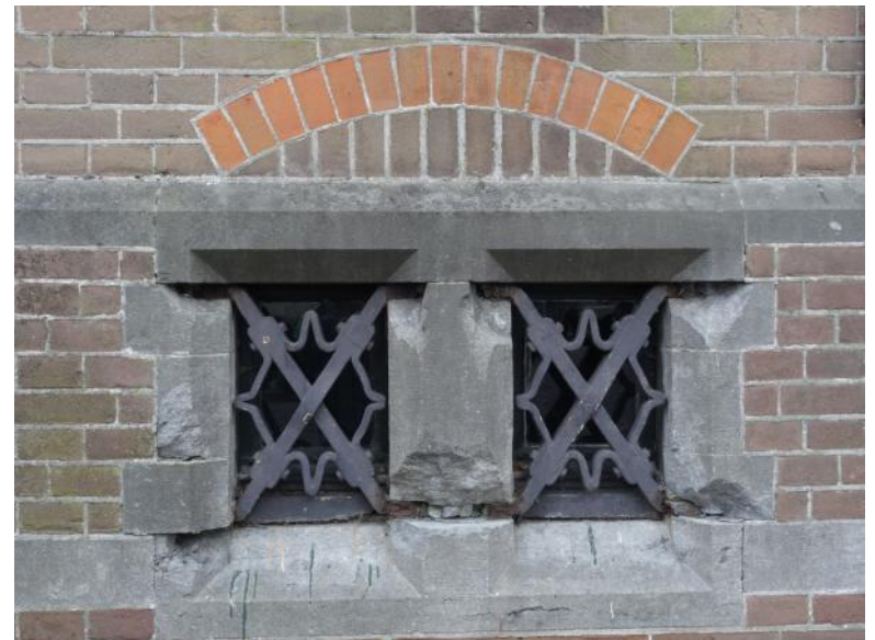
Afb. 5.24 De kelderramen in de pleingevel zijn voorzien smeedijzeren voorzethetwerk.
