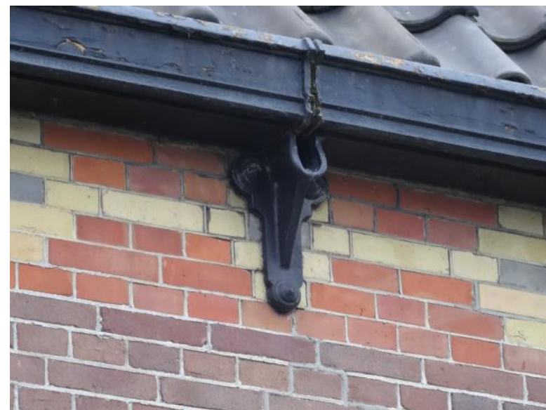
Afb. 5.12 De dakgoten worden gedragen door om en om een gemetselde en een gietijzeren steun op de sierlijst.
