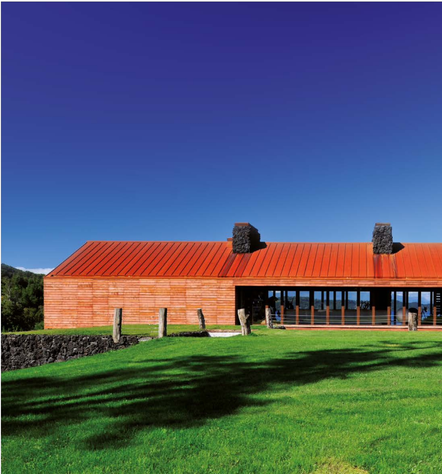
Casa Maitén - Arquitecto: Cristian Hrdalo - Producto: Revestimiento CD 500 SL
