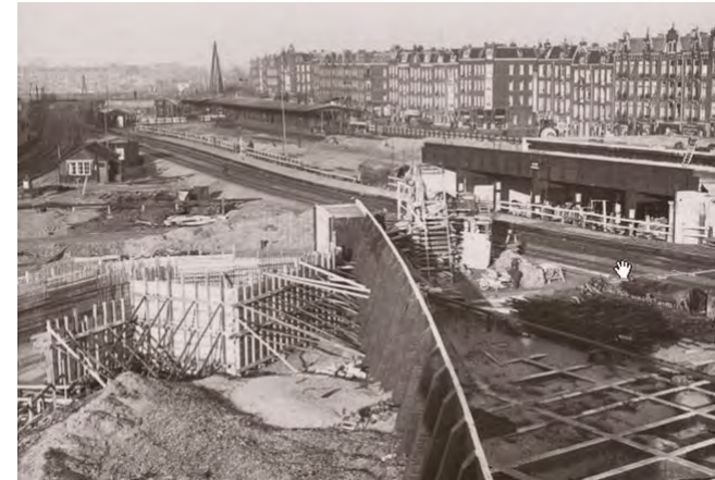
Aanleg van de spoordijken, 1936. Op de achtergrond het voormalige station Muiderpoort I. [HUA]
