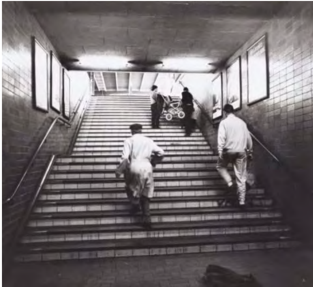
Toegang tot het perron vanuit de perrontunnel, 1989. [SAA]
