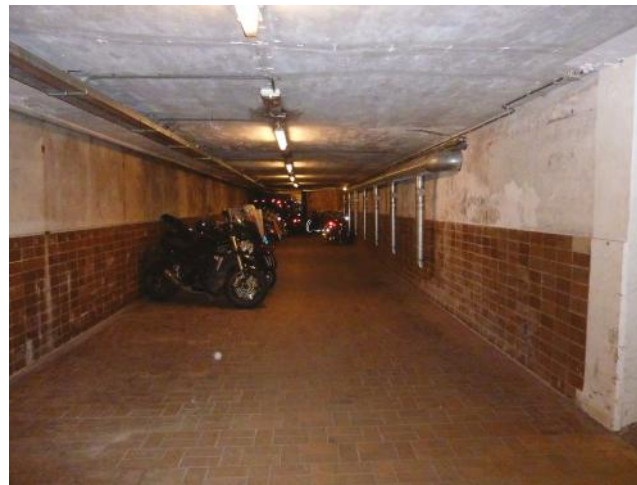
Perrontunnel 2015. Een deel van de oorspronkelijke stenen vloer en de tegelbekleding op de wanden is nog aanwezig.
