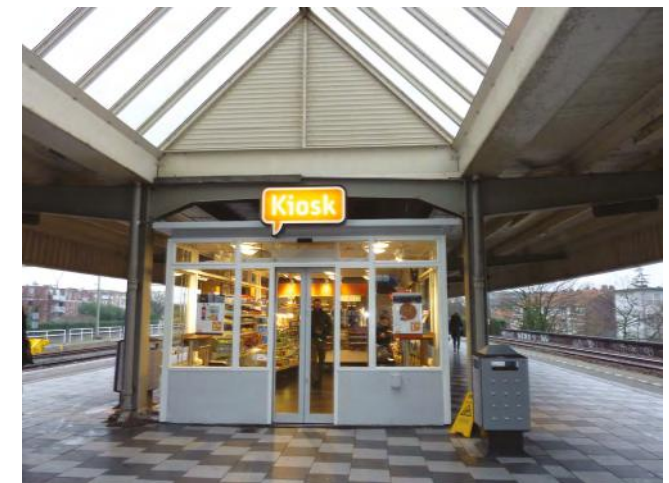
Kiosk op perron 1 (oostzijde). Voorheen was dit een wachtruimte op het perron.
