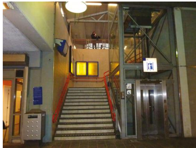
Perrontoegang in de onderdoorgang naar de Celebesstraat, aangelegd bij de verbouwing in 1998-2000.
