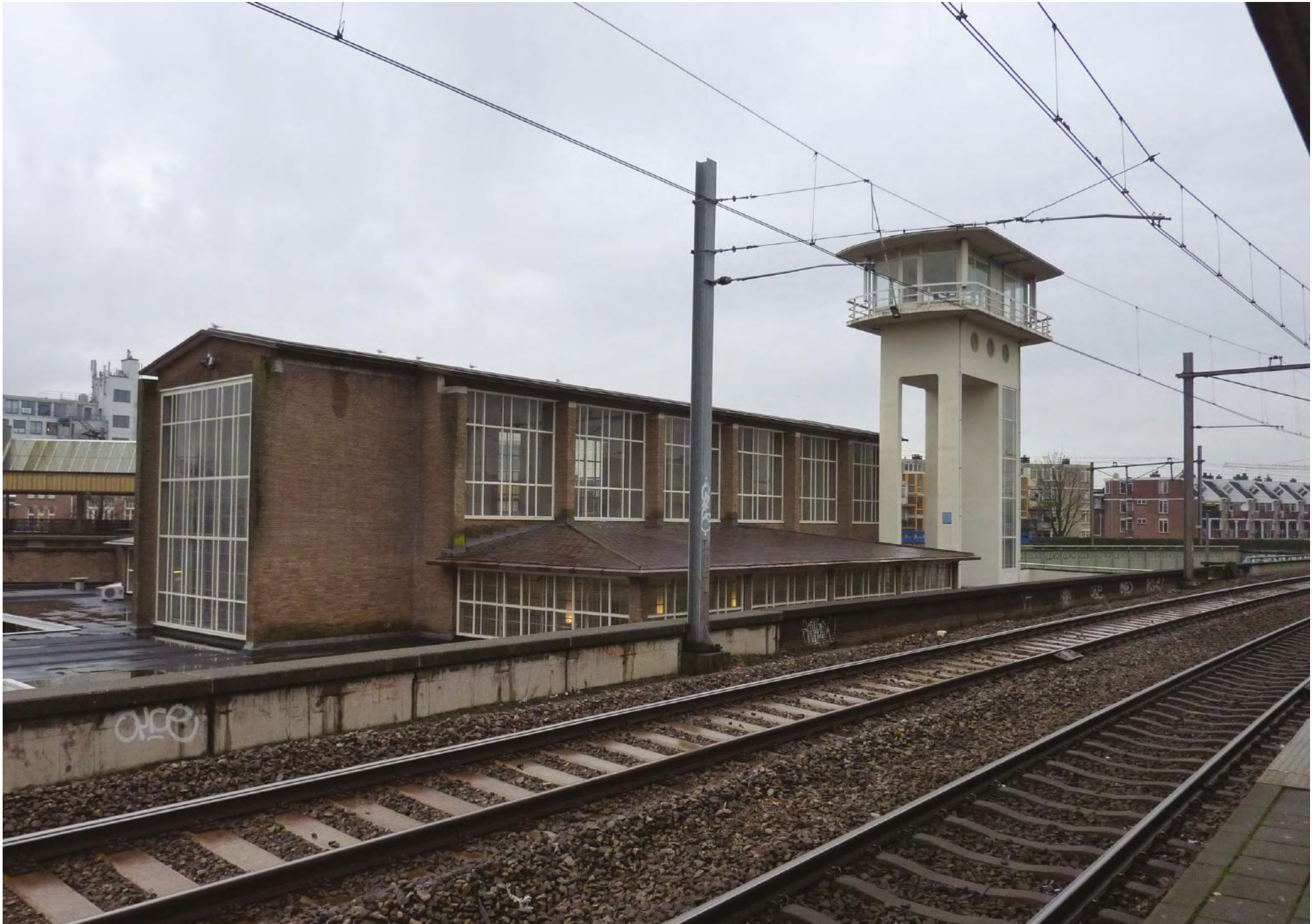
Station Muiderpoort met het seinhuis, gezien vanaf de spoordijk naar Amersfoort (perron 1)
