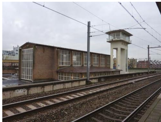
Oostgevel, gezien vanaf het spoor naar Amersfoort
