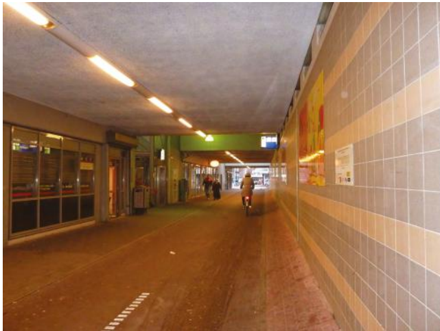
Voetgangers- en fietstunnel naar de Celebesstraat. Bij de verbouwing in 1998-2000 werd de tunnel verbreed en het fietspad toegevoegd.
