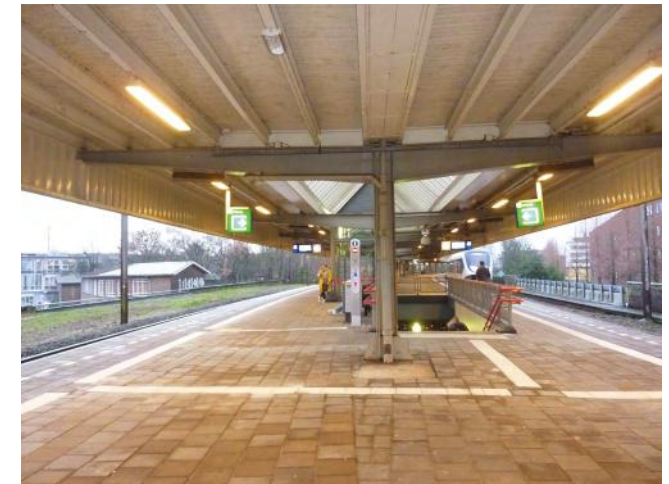
Perronoverkapping van de lijn naar Utrecht (perron 2). In tegenstelling tot perron 1 heeft de overkapping maar een rij staanders.
