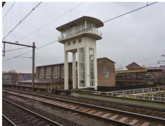
Het seinhuis, gezien vanaf de spoorijk naar Amersfoort
