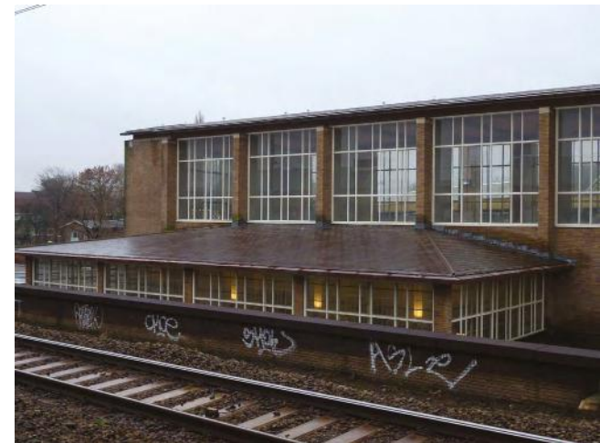
Oostgevel en dak van de vleugel met oorspronkelijke fietsstalling gezien vanaf het spoor naar Amersfoort.
