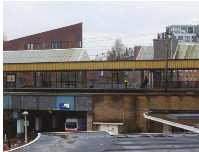
Aanzicht van de perronoverkapping met de daklichten en de golfplaten afdekking van de zijanten.
