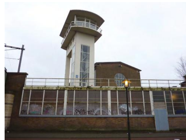
Noordgevel tussen de viaducten over de Insulindeweg. De raamstrook verlichtte voorheen de achtergelegen tunnels, de openingen zijn nu van binnenuit dichtgezet.
