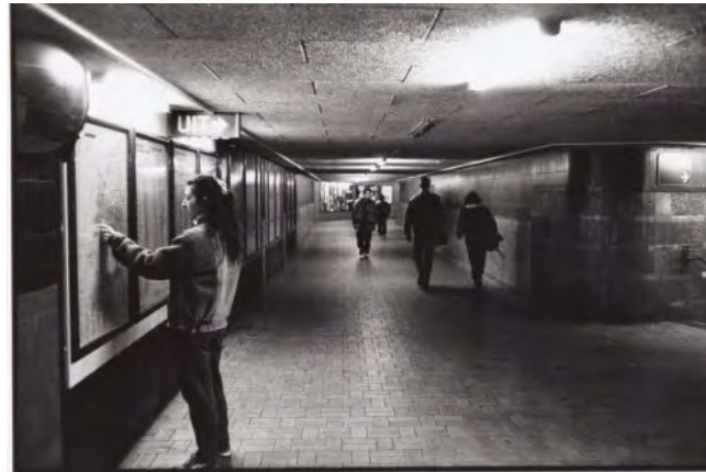
Perrontunnel 1990. Het daglicht via de koekoek is verdwenen doordat bij de tunnels de raamstrook is dichtgezet. De koekoek lag ter hoogte van de informatiebord op de foto. [SAA]
