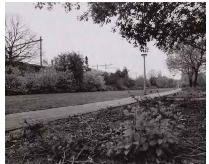
Groene inrichting van de spoordijk ter hoogte van de Polderweg, 1997. [SAA]
