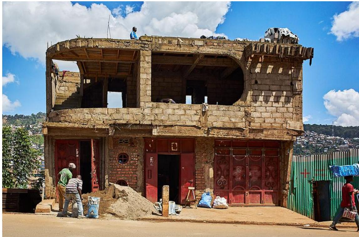
**Pour accélérer la construction, des blocs de béton préfabriqués, coulés directement sur place, sont empilés sur la dalle en plein séchage. Ces blocs serviront à construire les murs du niveau suivant.**
