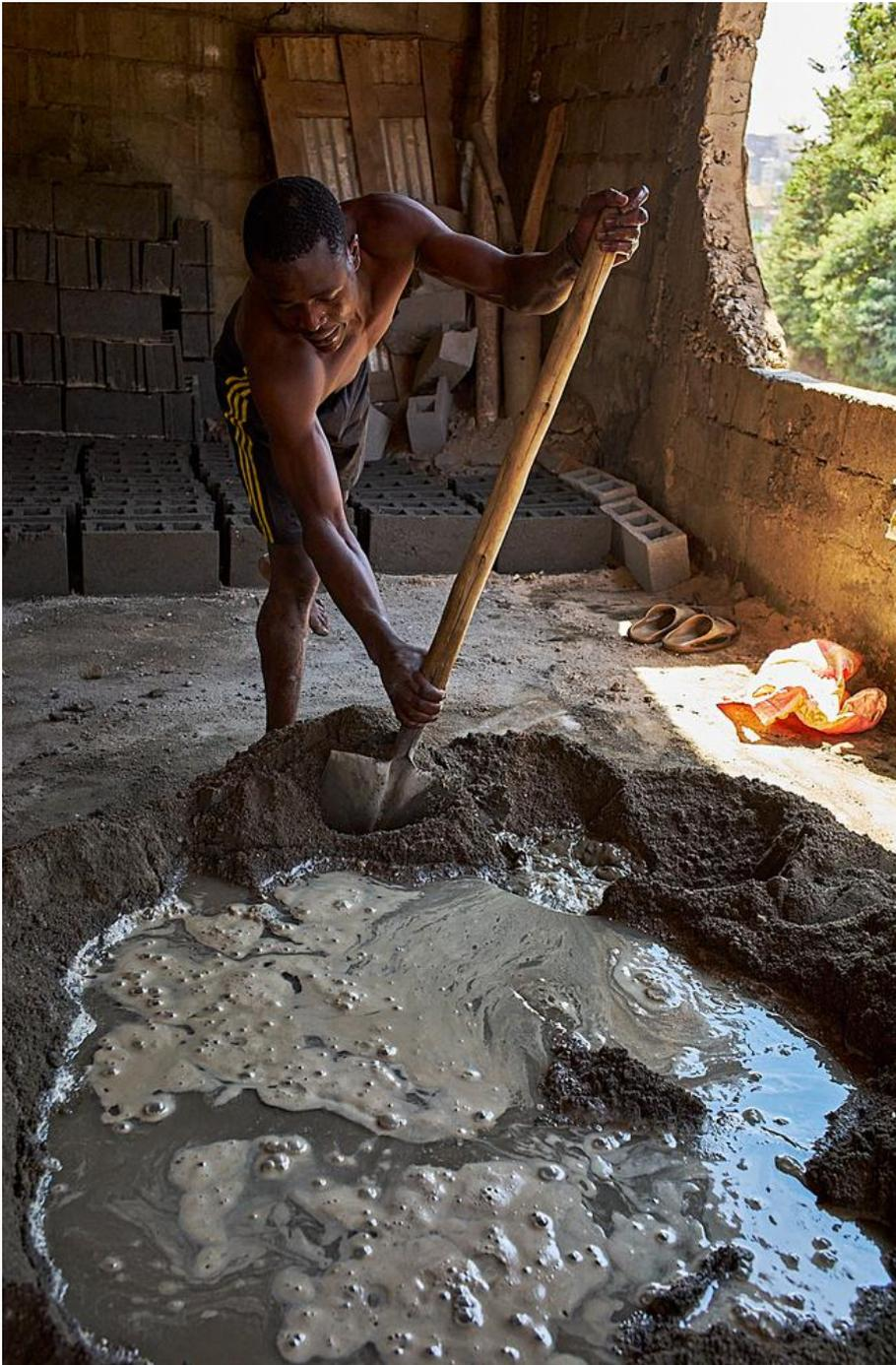
**Ce maçon mélange rythmiquement du sable, du ciment et de l'eau pour obtenir un béton lisse. Ce mélange essentiel sera utilisé pour créer des blocs, un matériau de construction courant pour les murs. Malgré les exigences physiques, le maçon expérimenté mélange le béton avec une aisance pratique.**
