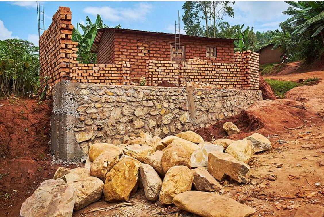
**Voici un chantier où, après la construction des fondations du bâtiment avec des pierres et du béton, les murs sont construits avec des briques et, au lieu d'utiliser du béton, ils utilisent un mélange de boue et d'eau.**
