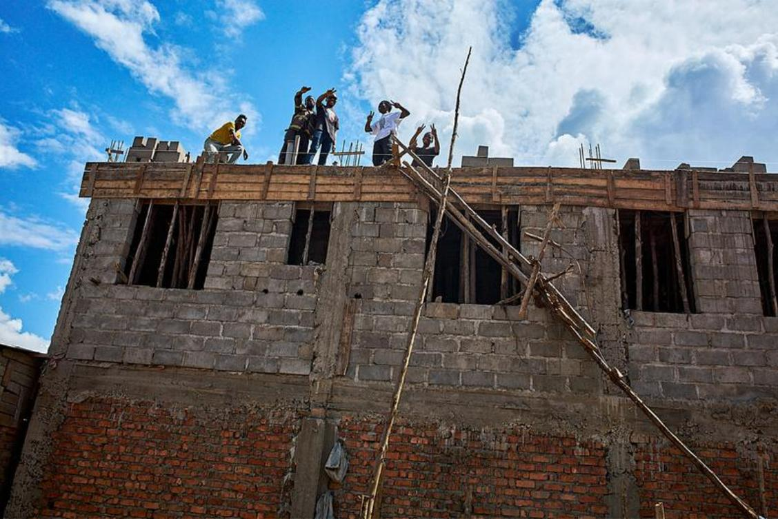
Ces images donnent un aperçu des méthodes de construction à Bukavu. La brique est souvent utilisée pour les murs du rez-de-chaussée en raison de leur solidité.
