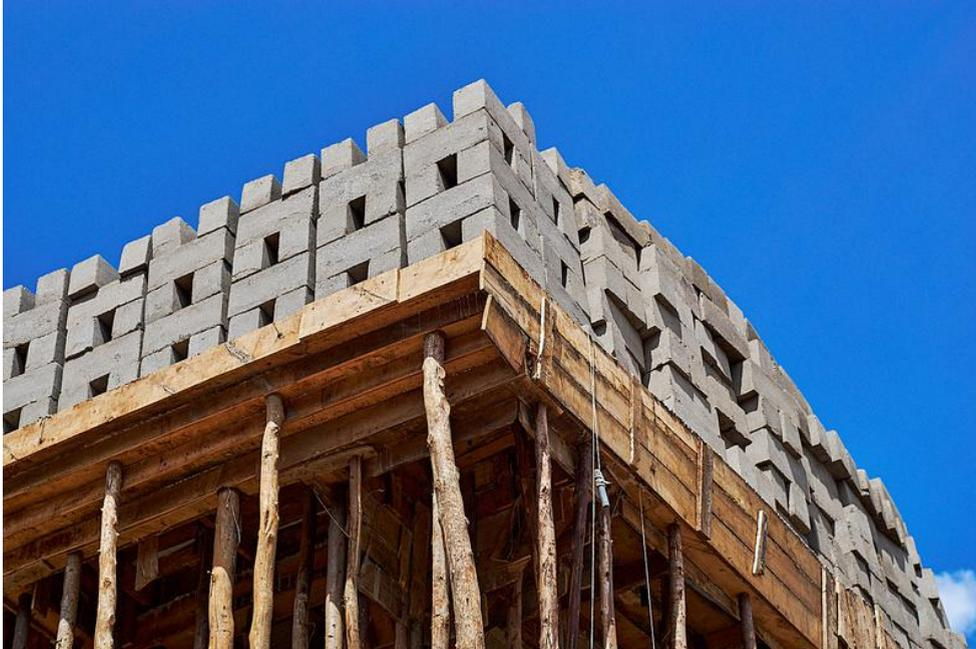
**L'image montre une pile de blocs de béton préfabriqués sur le chantier et empilés sur la dalle. Ces blocs seront utilisés pour construire les murs du niveau suivant du bâtiment. Ces blocs sont un type de matériau de construction similaire aux briques, mais ils sont souvent produits sur place pour des raisons de commodité.**
