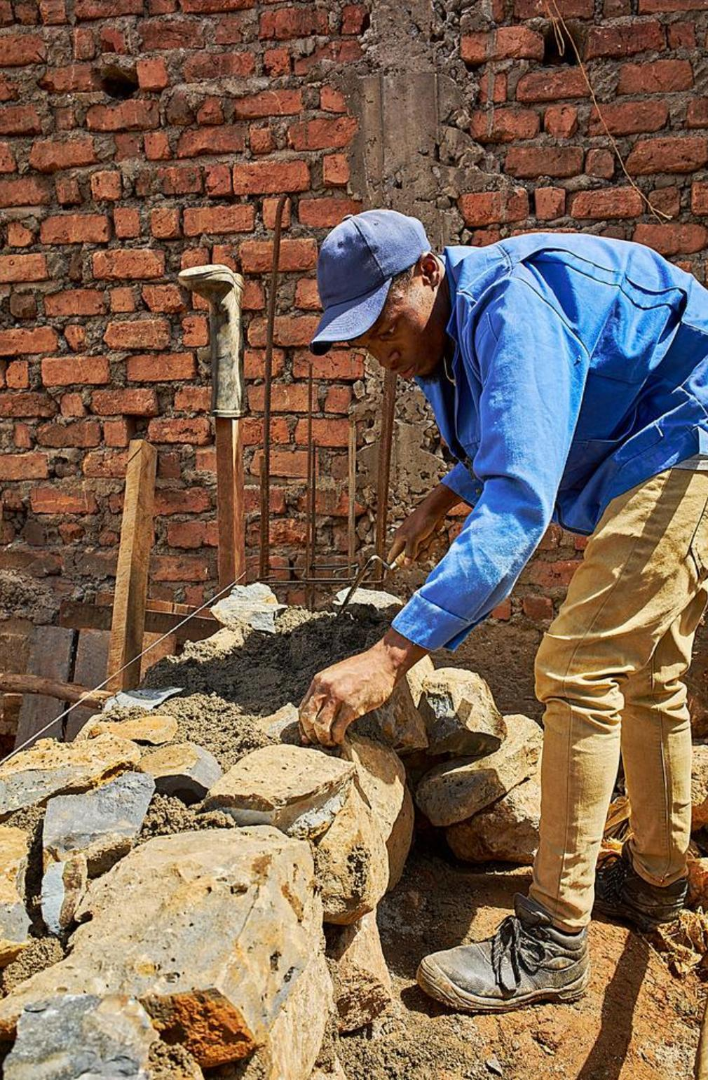
**Ce maçon est en train de construire progressivement un mur de soutènement, à l'aide d'une truelle et à partir de pierres et d'un mélange de mortier. La disposition précise des pierres et l'utilisation prudente du mortier témoignent de l'art requis pour construire des fondations solides et sûres, ce qui est nécessaire pour construire sur des pentes.**
