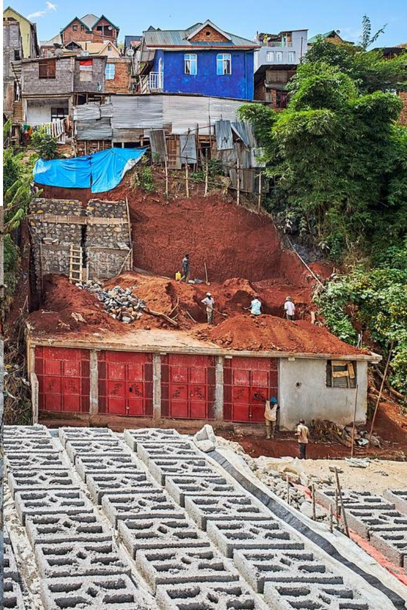
Remarquez que les blocs finis sont empilés au niveau le plus élevé de la structure pour être séchés. Il faudra des semaines pour que ces blocs durcissent avant d'être suffisamment solides pour la construction.
