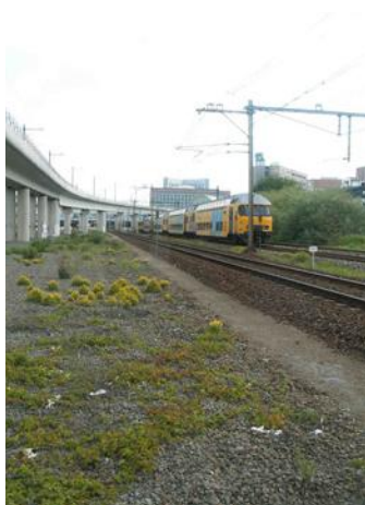
Ballastbed met Gele helm- bloem bij Amsterdam-Sloterdijk
