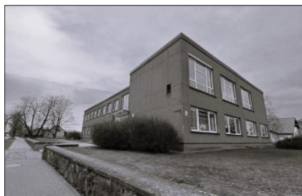
Topošā bibliotēkas ēka 2025. gada aprīlī.
