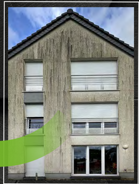
TAFF Fassadebotz zu Wuelessen
